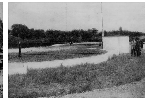
Estação depuradora. Ferreira do Alentejo
