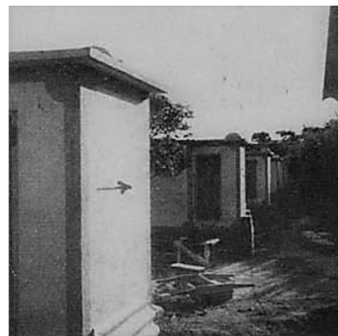
Câmaras de visitas dos poços de captação da Quinta da Bomba
