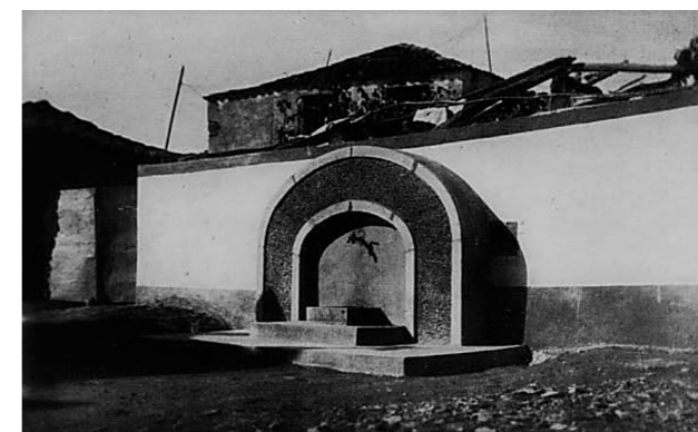
Abastecimento de água a Pereiro Tabuaço
