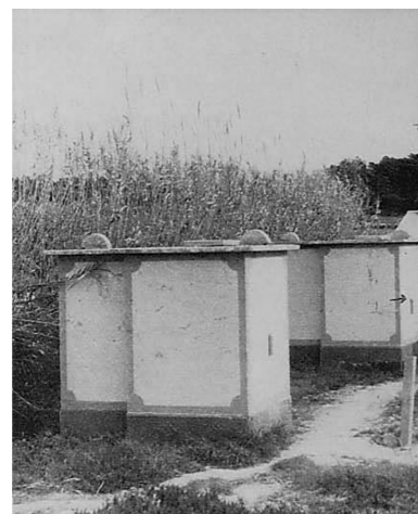
Câmaras de visitas dos poços de captação da Quinta da Bomba
