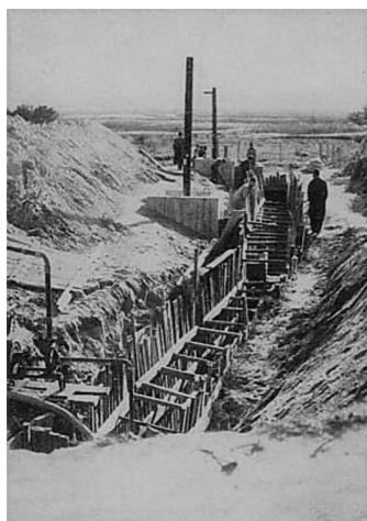
Captações da Quinta da Bomba
