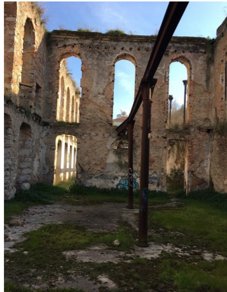
Figura 17 Interior da Chemina
