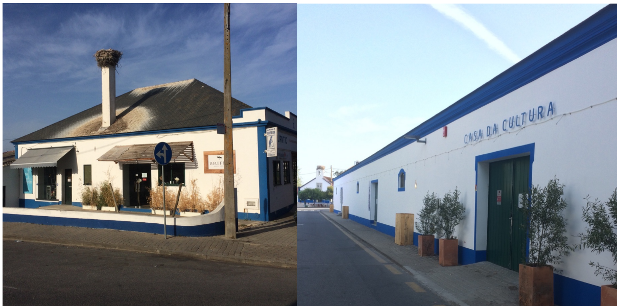
Figura 3.3 - Antigos edifícios requalificados
