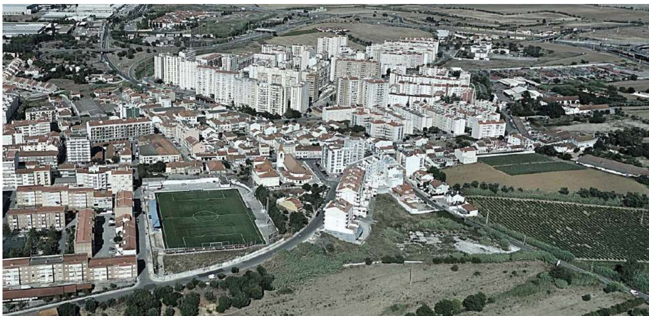
Figura 1 Fotografia aérea do Carregado (Terceira Dimensão, 2008)
