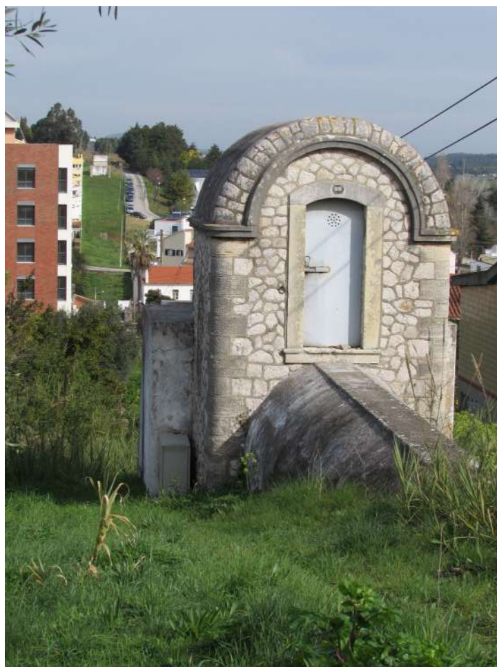
Casas de água do Sifão 29, visto de Paredes
