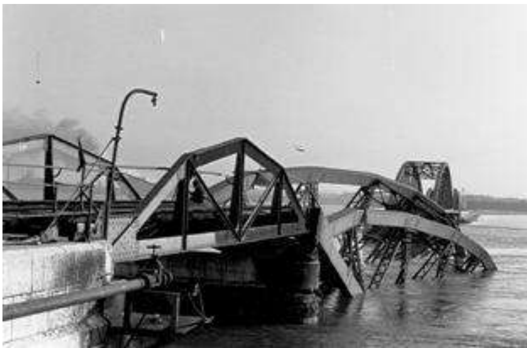
Fig.10: Ramal do Seixal destruído
