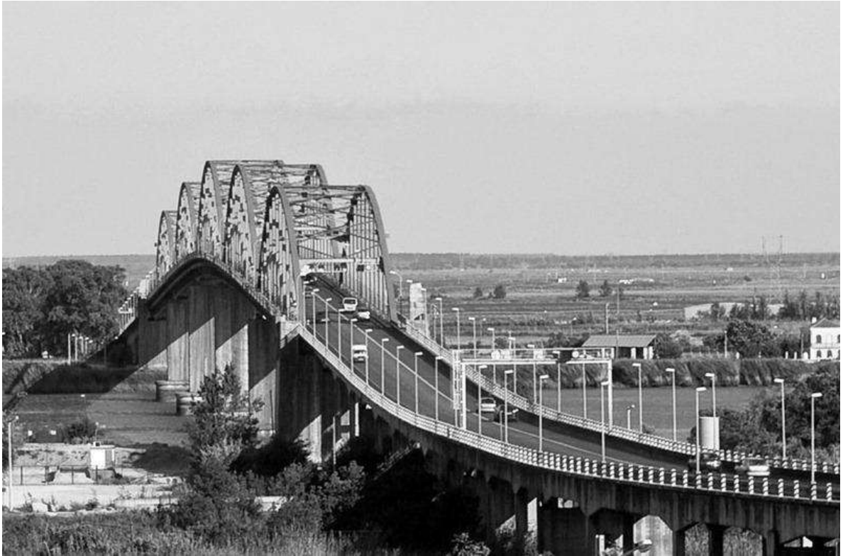
Fig.8: Ponte Marechal Carmona
