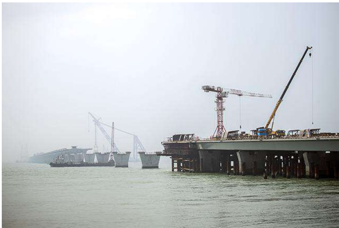
Fig.16: Construção da ligação Macau - Zhuhai - Hong-Kong
