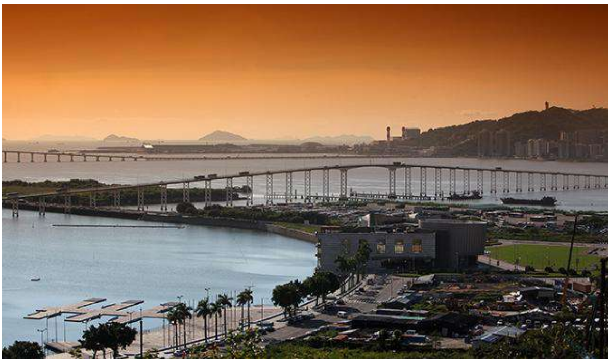
Fig.13: Ponte Governador Nobre de Carvalho, em Macau
