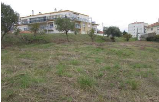
Aqueduto Alviela na zona de Paredes, na Rua do Pedrogão
