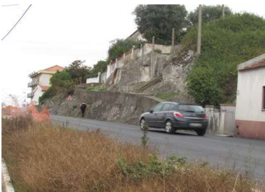
Zona onde passa o Aqueduto na N1, entre Paredes e Alenquer
