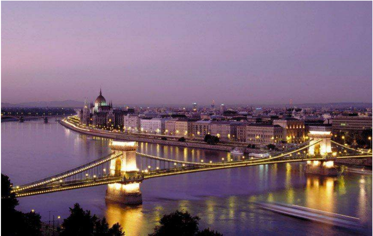
Fig.17: Ponte Széchenyi, em Budapeste
