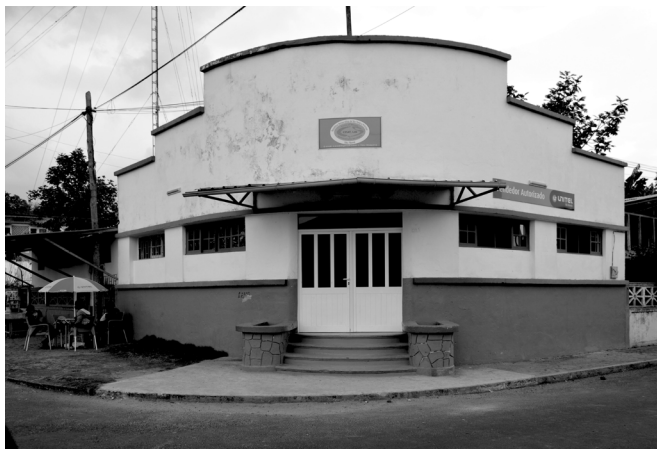
20. Antigo edifício dos CTT, actual loja da Unitel © Dídia Rita, 2016
