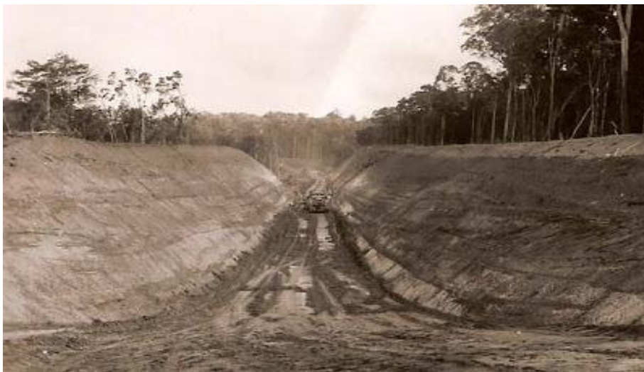
Figura 7: Terraplanagem para construir a Estrada de Ferro do Amapá, 1954.
