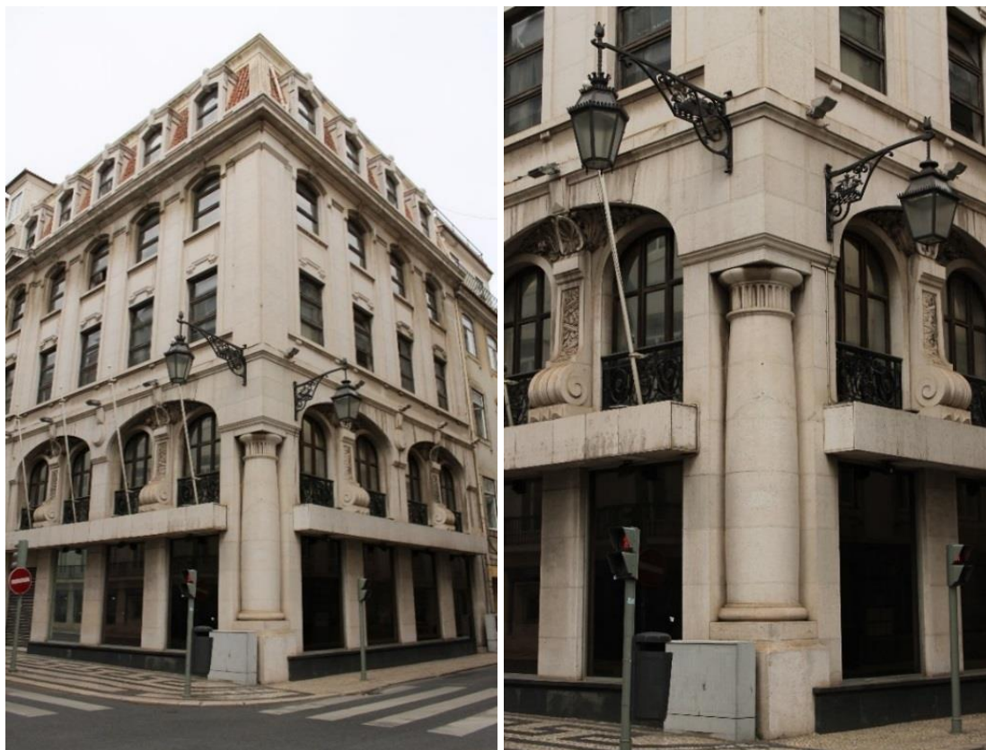
Imagem 32- Fotografias do edifício situado na rua Áurea Nº40 e pormenor da coluna, da autora.
