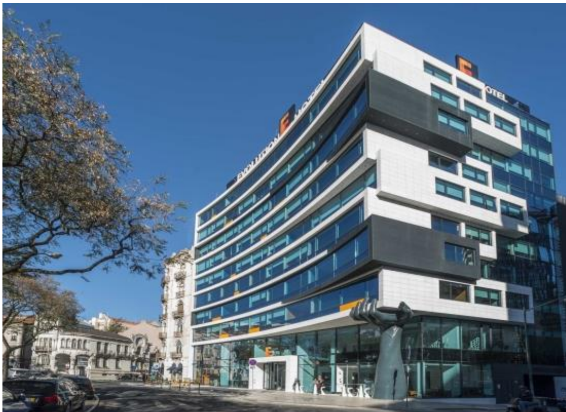
Imagem 54- Fotografia do aspeto atual do edifício, In CML em Entrecampos.
