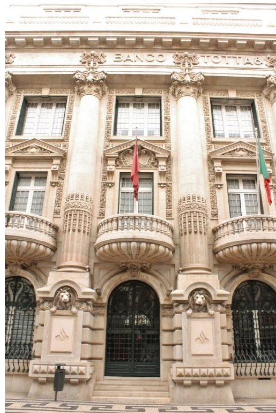
Imagem 43- Fotografia de parte do Alçado Principal do Banco Totta & Açores. Fotografia da autora.
