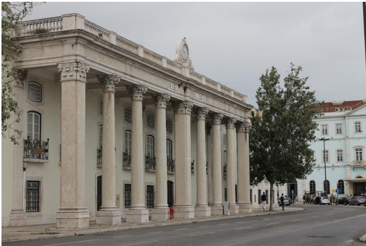
Imagem 42- Fotografia onde é possível comparar o estado atual da rua. Fotografia da autora.
