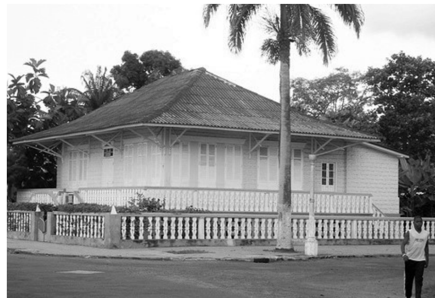
Figura 6. Casas coloniais de planta quadrangular construídas no período pré-independência. (Fonte: Viagem a S. Tomé e Príncipe, 2010)
