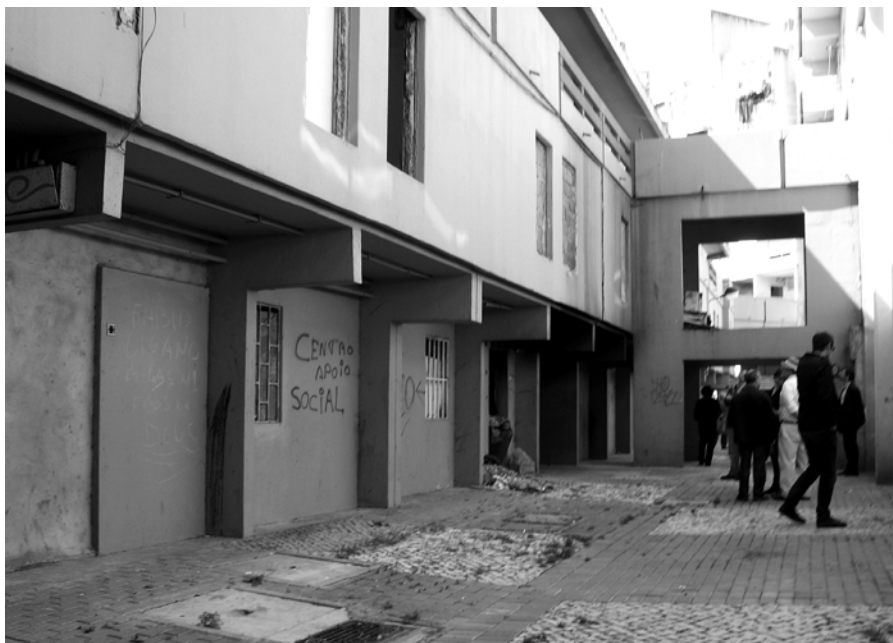
Figura 8. Zona J, galeria interior, antigo "corredor da morte". (Fonte: fotografia dos autores, 2011)
