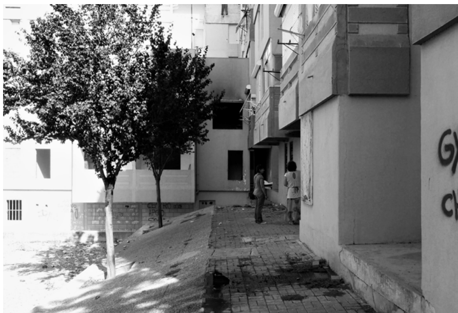
Figura 18. Zona J, acessos ao lote em banda. (Fonte: Fotografia dos autores, 2011)
