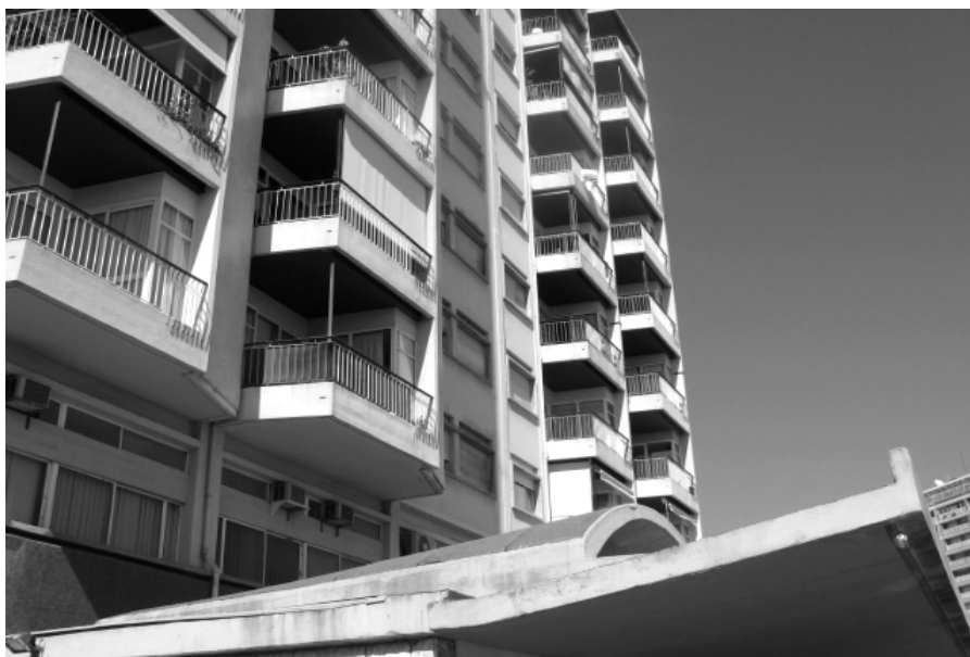
Figura 3. Bloco das Águas Livres - Lisboa. Vista geral. (Fonte: Fotografia T. Madeira da Silva, 2009)
