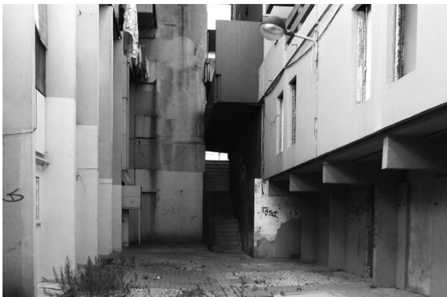
Figura 9. Zona J, galeria interior. (Fonte: Fotografia dos autores, 2011)
