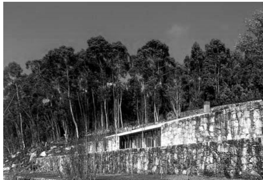
Figura 15. Casa em Moledo – Vista dos socalcos. (Fonte: https://spar487design2.wordpress.com )
