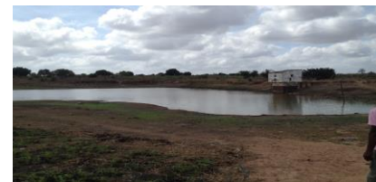
FIGURA 2- RESERVA DE ÁGUA ZONA D/MAPUTO
