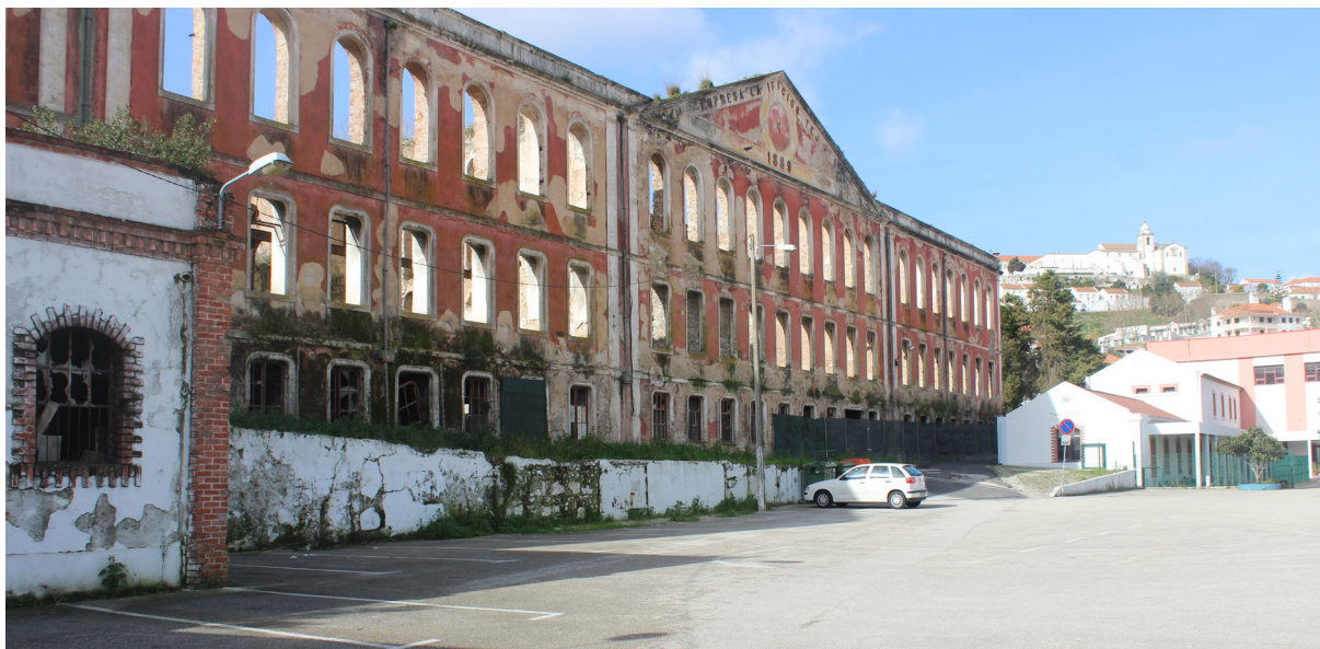
Figura 61. Fábrica após o Incêndio (fonte: autora )
