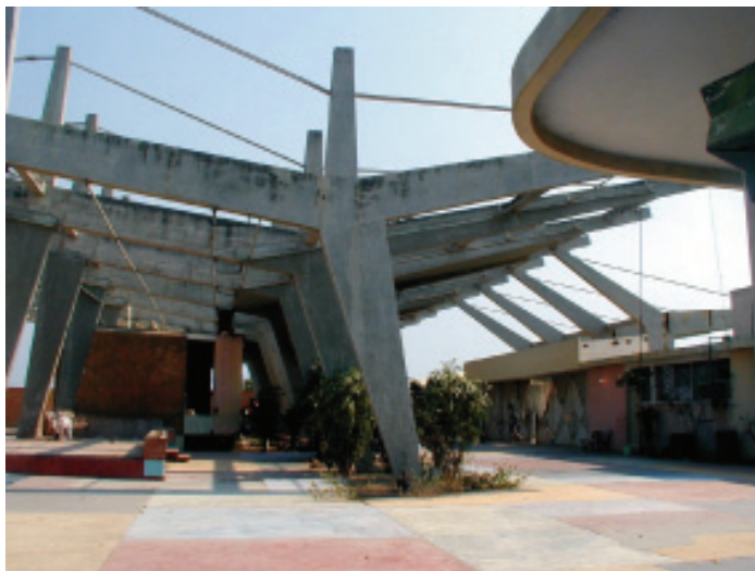
Figura 15: A estrutura “limpa” do Cine Esplanada Flamingo, Lobito, 1964 Foto: Cristina Salvador, 2005
