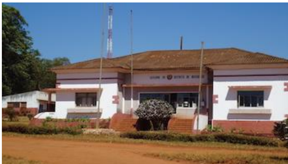
Figura 5.21 – Sede do Governo do Distrito de Mossurize (ou Administração) (foto da autora, Espungabera, 2014)
