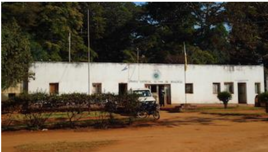
Figura 5.9 – Comando Distrital da PRM de Mossurize (foto da autora, Espungabera, 2014)
