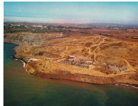
Figura 4, 5 e 6: Sines durante as obras de industrialização.
