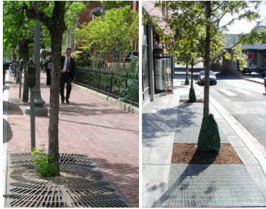
Figura 51: Figura ilustrativa da forma correta de colocação das grelhas de proteção nas zonas ajardinadas em locais transitáveis (CoolTownStudios, 2013).
