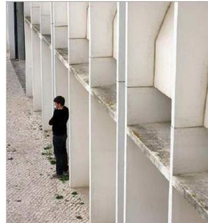
Fig. 59 – Painéis de betão pré-fabricados ISCTE I
