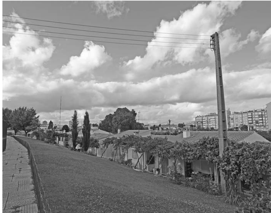
FIG 46 Vista atual das habitações de um piso. Quintais e arranjos exteriores.
