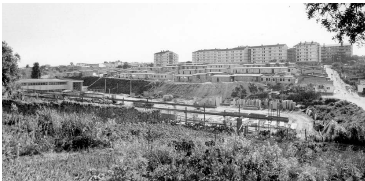
FIG 35 Estaleiro das obras na Zona Norte, 1ª fase do plano.
