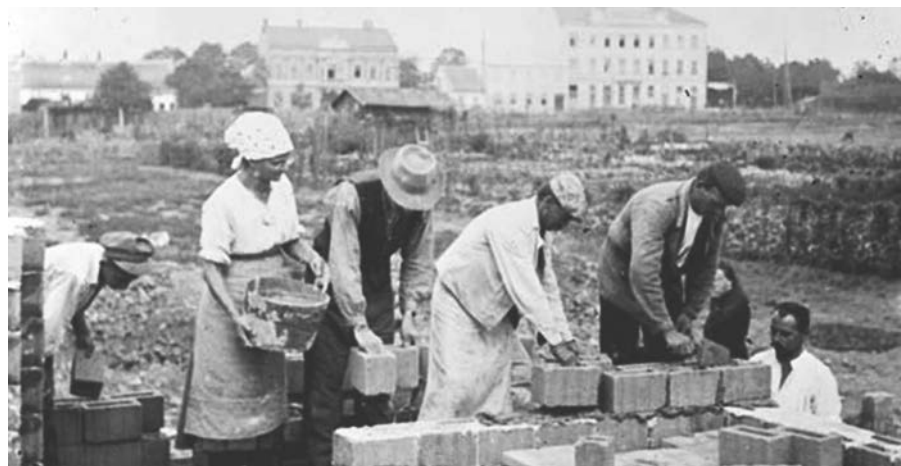
FIG 4 Reconstrução de habitações por comunidades Do It Yourself (DIY) com desalojados e sem-abrigo, após 1ª guerra mundial, utilizando a AC, Viena 1919. Fotografia: Siedlung Rosenhügel
