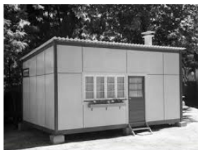
FIG 11 Protótipo da Lusalite utilizada na Quinta da Calçada e Boa Vista
