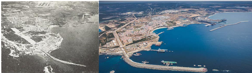
Figura 4. Vistas aéreas do complexo urbano-industrial-portuário de Sines inicialmente. Atualidade do mesmo.
