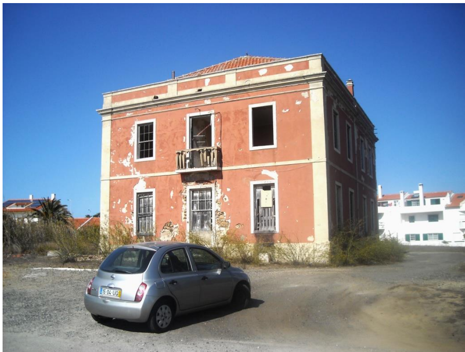
I. 7 – Fotografia dos autores – Casa de Santa Isabel
