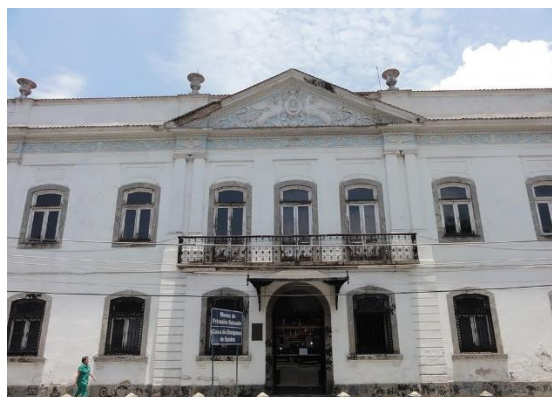
Fig. 67 – COSTA, Tiago – Casa da Marquesa de Santos.
