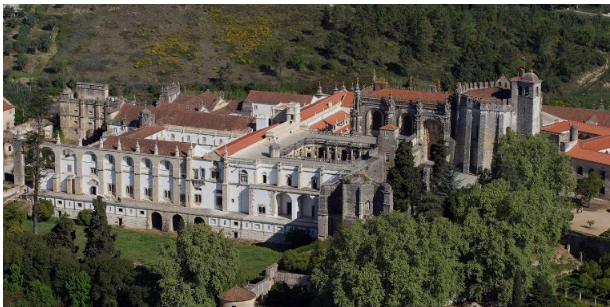
Figura 7. Planta do Convento de Cristo, Tomar. Figura 8. Vista aérea do Convento de Cristo, Tomar.
