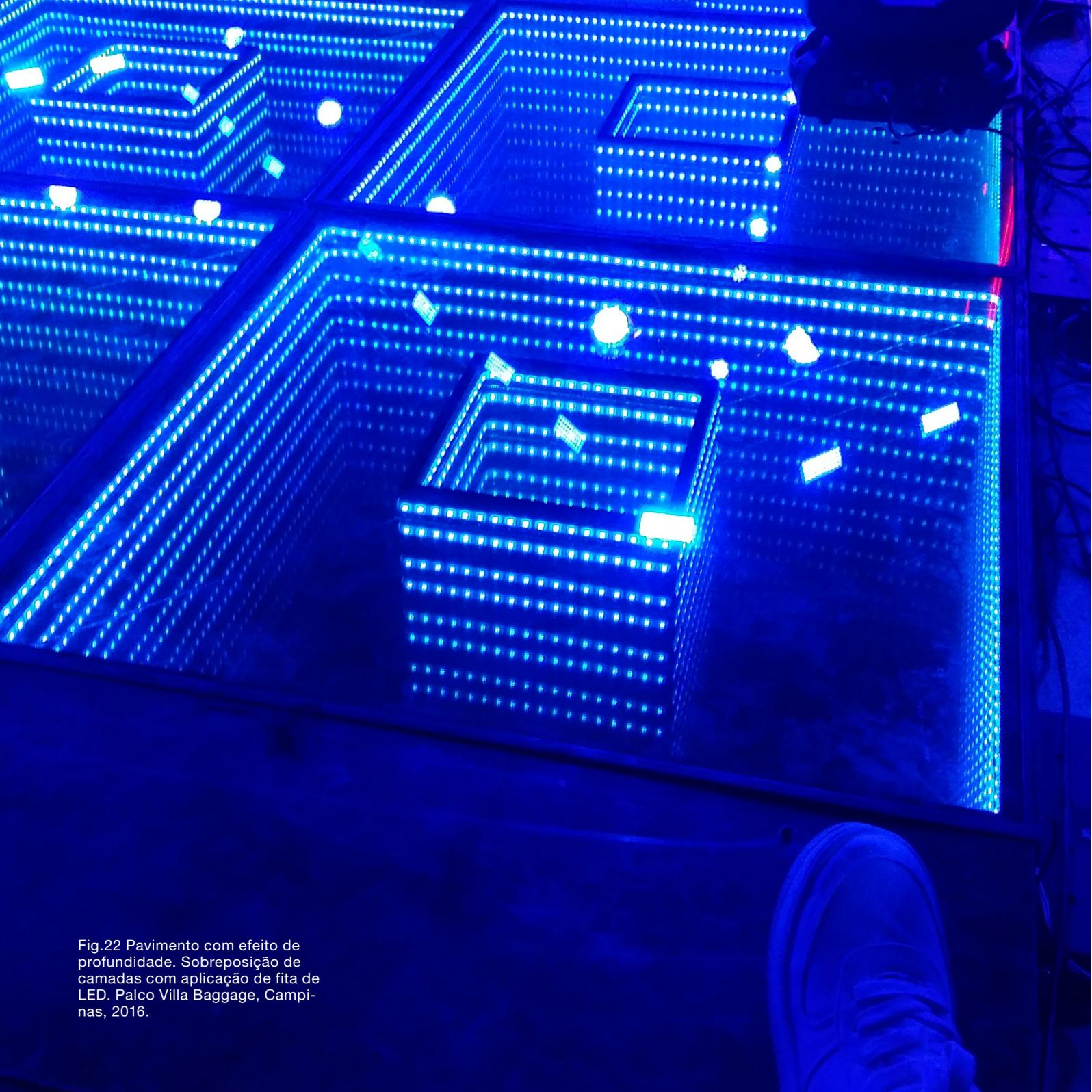
Fig.22 Pavimento com efeito de profundidade. Sobreposição de camadas com aplicação de fita de LED. Palco Villa Baggage, Campinas, 2016.
