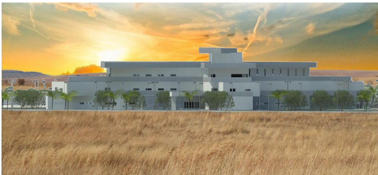
Figura 5 - Vista geral do Pólo Tecnológico de Benguela
