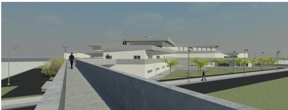
Figura 14 - Vista da área da rampa de acesso a estra principal
