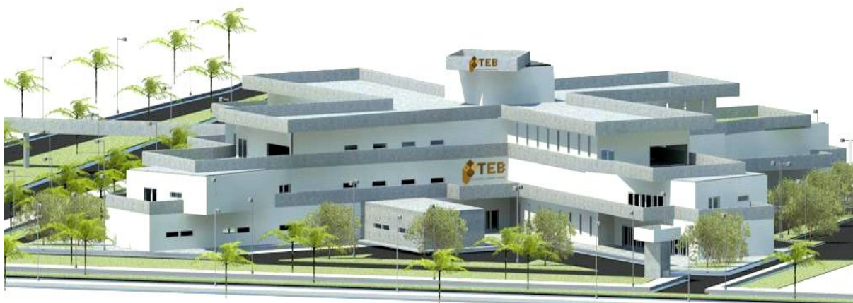
Figura 4 - Detalhe da entrada principal e a vista do reservatório de água no topo do edifício
