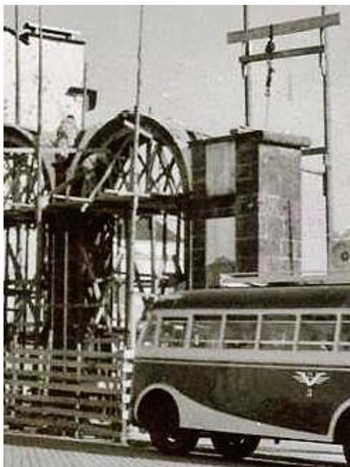
Fig. 42 – Demolição controlada das Portas da Cidade, para serem posteriormente realocizadas, 1954.
