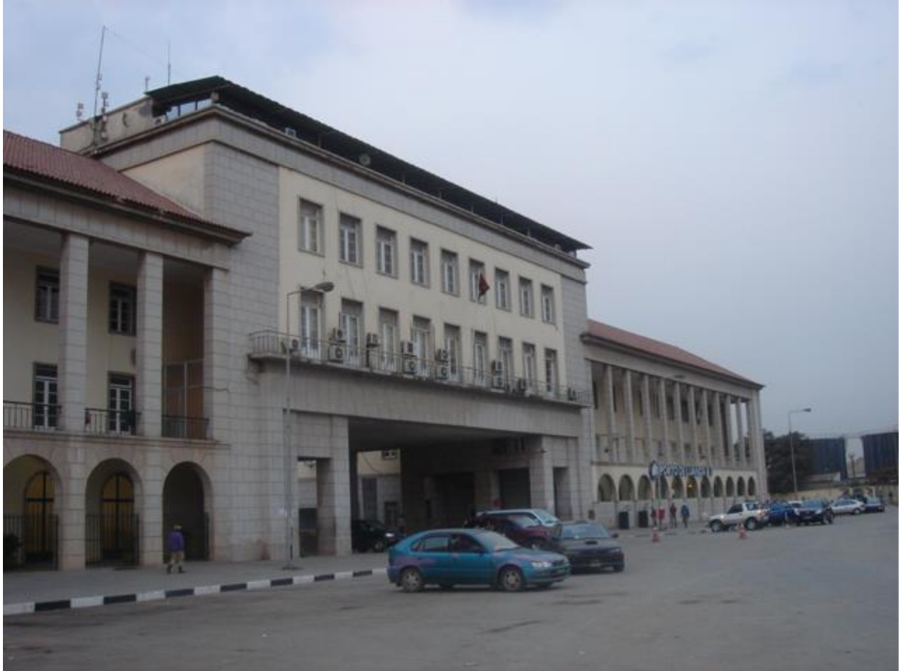
Fig. 16 Instalações do porto de Luanda, Eurico Pinto Lopes/GUC, 1948. Foto: Ana Vaz Milheiro, 2009
