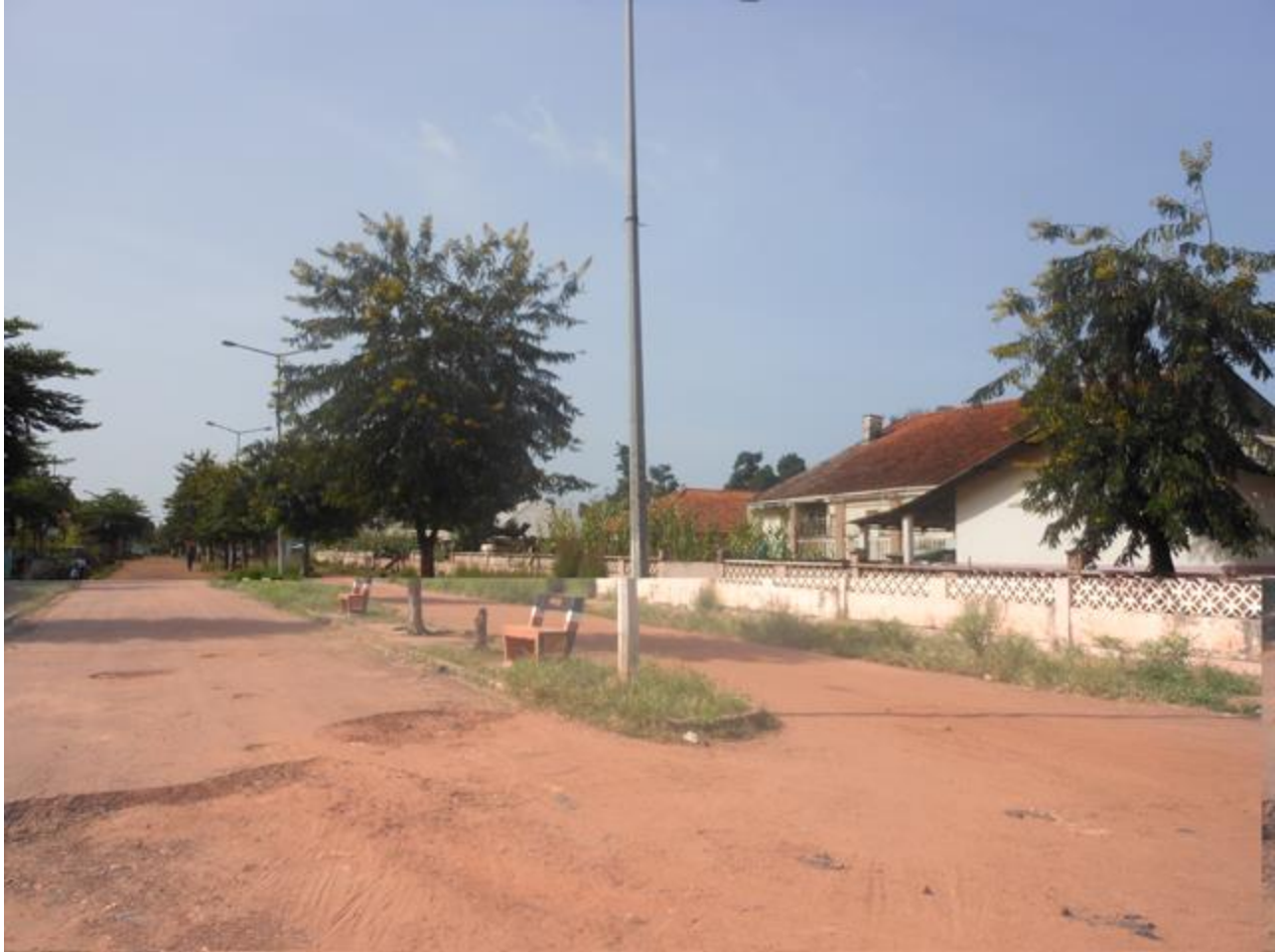
Fig. 12 Gabu, uma das avenidas com placa central e postes de iluminação pública. Foto: Ana Vaz Milheiro, 2011
