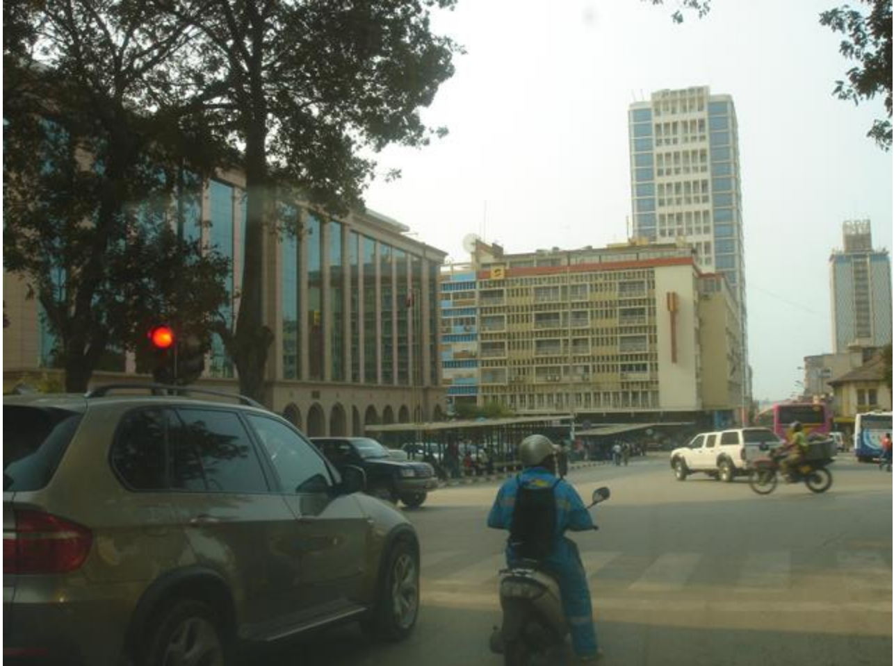
Fig. 18 Ministério das Finanças, antigo Edifício dos Serviços de Fazenda e Contabilidade de Luanda, João António Aguiar/GUU, 1953, Largo da Mutamba. Foto: Ana Vaz Milheiro, 2009
