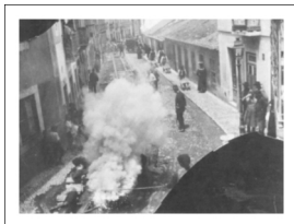
A colocação de carris constituiu um importante momento
