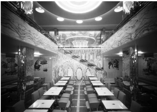
Fig.79- Escadaria de acesso à cave
