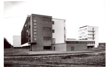
Fig. 31- Edifício Bauhaus em Dessau
