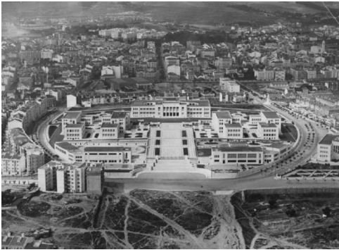
Fig.58-fotografia aérea de Pinheiro Correia aquando da sua conclusão - Arquivo do Atelier PMA
