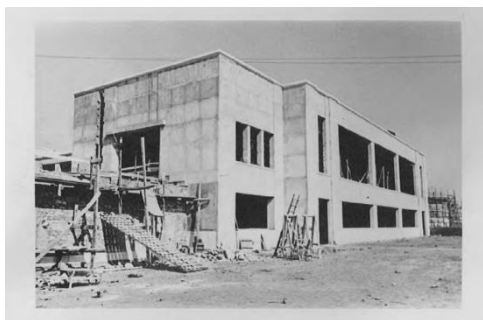
Fig.59- Fotografia do Pavilhão das oficinas em construção - Arquivo do Atelier PMA
