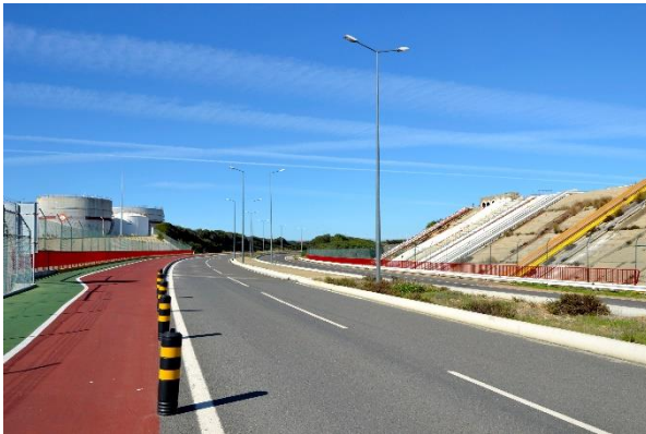
Estradas de acesso ao porto com ciclovias
