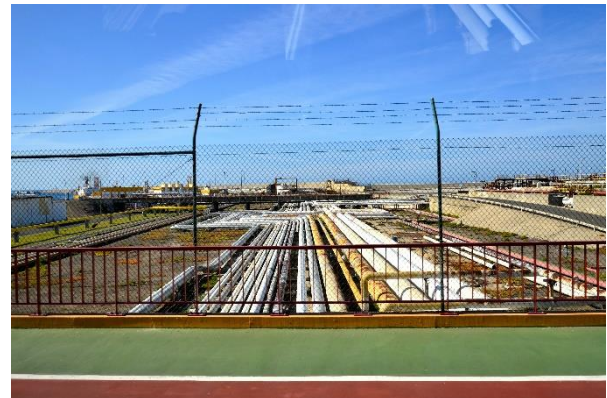
Passagem sobre os oleodutos
