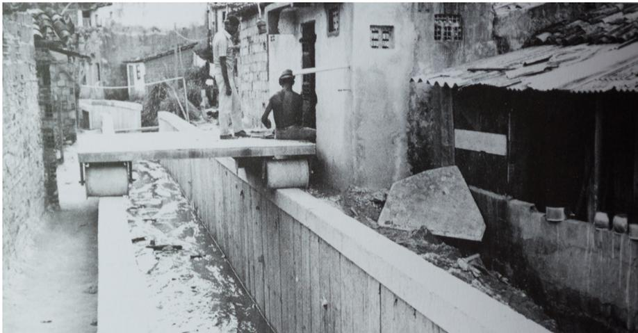
Fig. 27 Canal principal de escoamento
