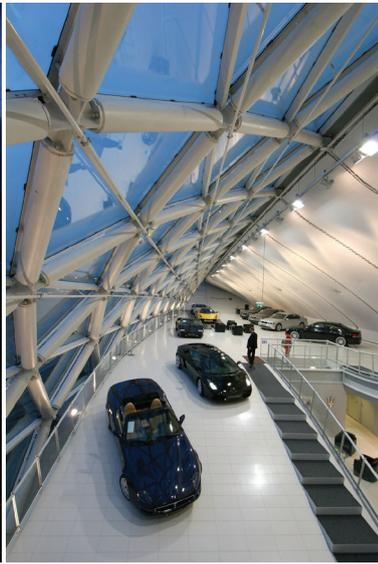
Fig. 30 – “A2 Cockpit”, projecto do atelier ONL concluído em 2006 – na imagem percebem-se facilmente alguns dos pontos (point cloud) que definem a estrutura (ONL, -2016).
