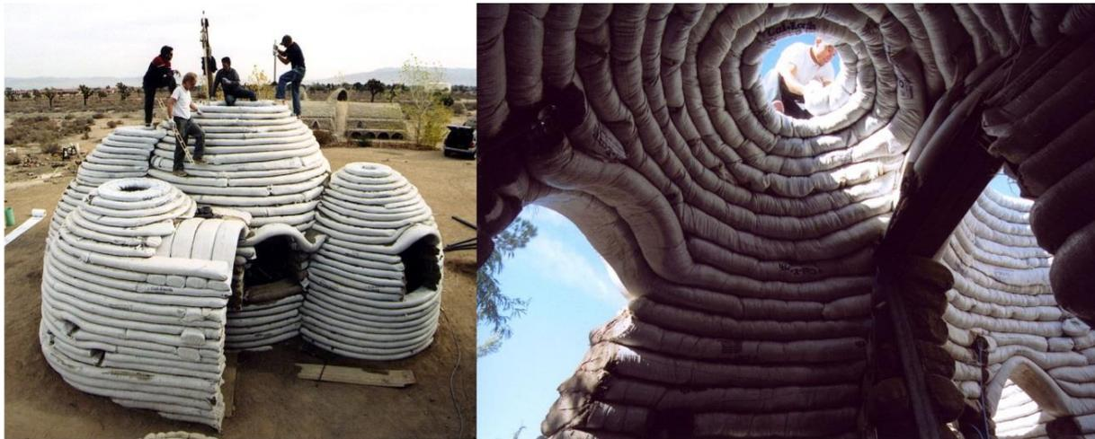
Figura 10 | Do lado esquerdo a construção de um protótipo em Ahwaz, Irão. Do lado direito é possível observar a cúpula a partir do seu interior (Fonte: Cal-Earth Institute, s.d.).
