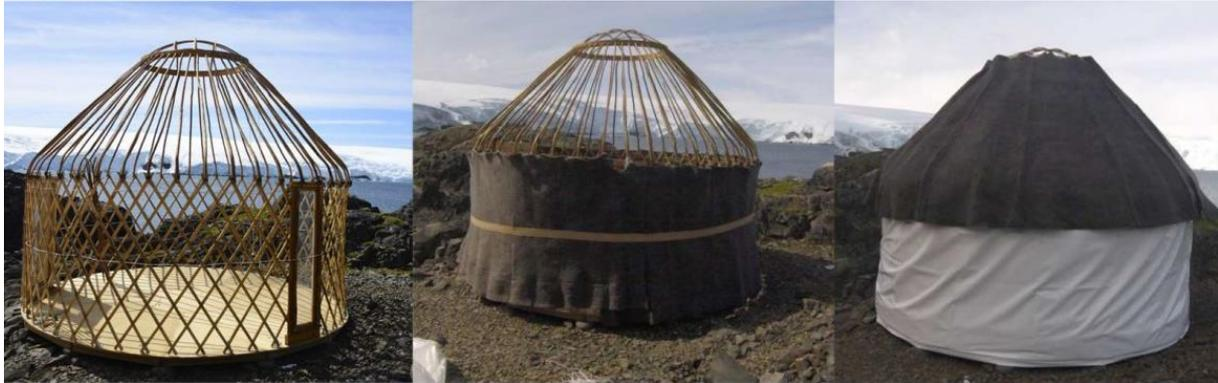
Figura 15 | Várias fases do processo de montagem do protótipo, instalado no glaciar Collins (Fonte: Apresentação FIL, POLARLODGE, 2016).
