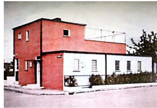
Fig. 34 - Habitação unifamiliar (nº19), de Bruno Taut. Exposição Weissenhofsiedlung (Estugarda, 1927). - Imagem capturada.
