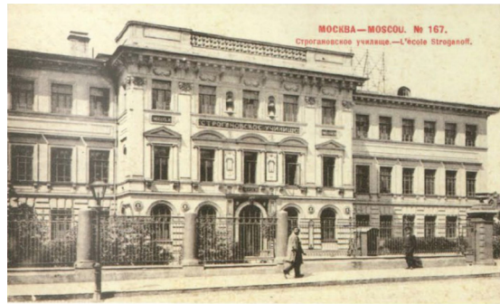
Fig. 44 - Escola Industrial e de Artes Aplicadas Stroganov (Rua Rozhdestvenka, Moscovo. 1900) – Edifício onde se realizou o 1ºSvomas. (Imagem capturada).
