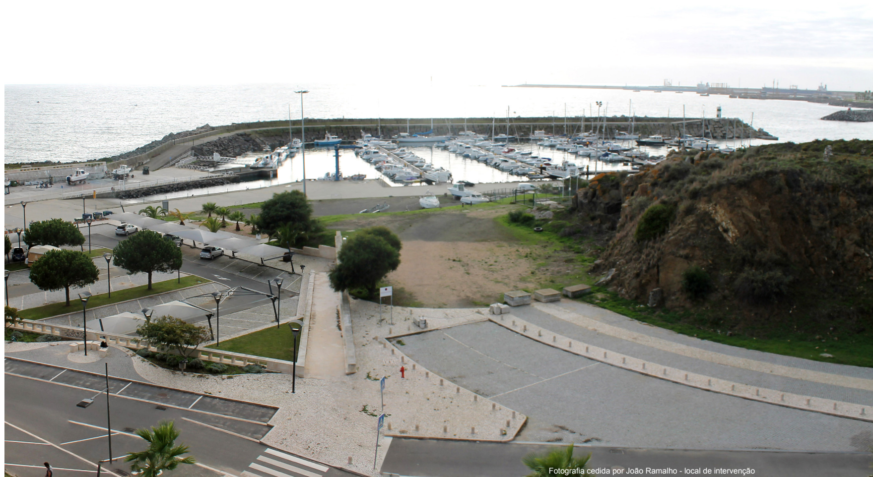
Fotografia cedida por João Ramalho - local de intervenção
