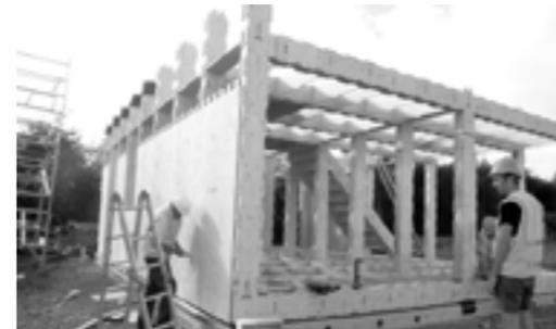
Fig. 39\_ Assemblagem dos elementos de revestimento. (Nurcery, 2016)
