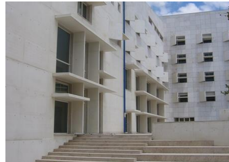
ISCTE-IUL, Lisboa, Arquitecto Raul Hestnes Ferreira, Exemplo de palas horizontais que fazem parte do corpo de construção
