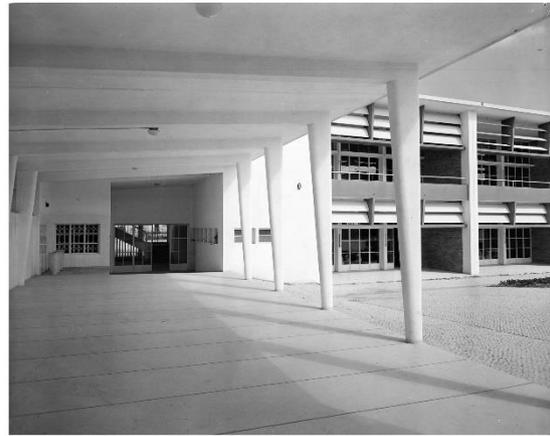
*Fig. 47 – Escola primária do Bairro de São Miguel (1956), à esquerda. Interior do equipamento escolar, onde se pode ver a laje elevada sobre pilotis e as palas pivotantes (1956), à direita.*
