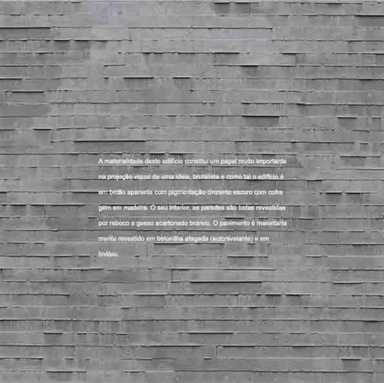
A materialidade deste edifício constitui um papel muito importante na projeção visual de uma ideia, brutalista e como tal o edifício é em betão aparente com pigmentação cinzenta escuro com cofragem em madeira. O seu interior, as paredes são todas revestidas por reboco e gesso acartonado branco. O pavimento é maioritariamente revestido em betonilha afagada (autonivelante) e em linóleo.
