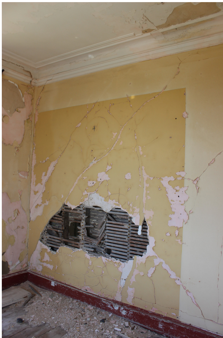
Parede de tabique no piso 1
