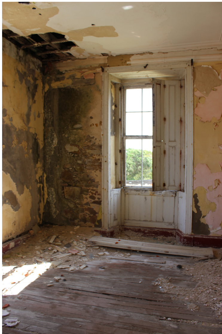
Quarto no piso 1
