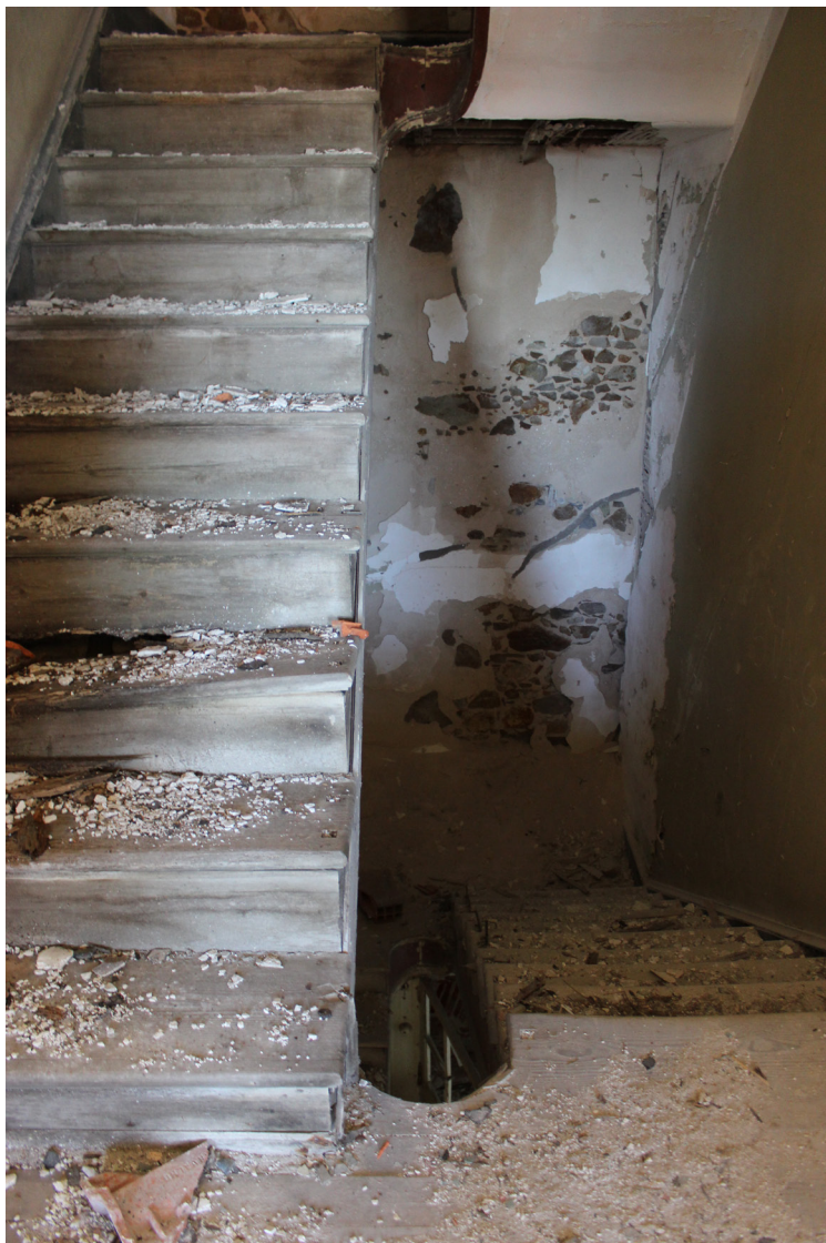
Escadas no piso 1
