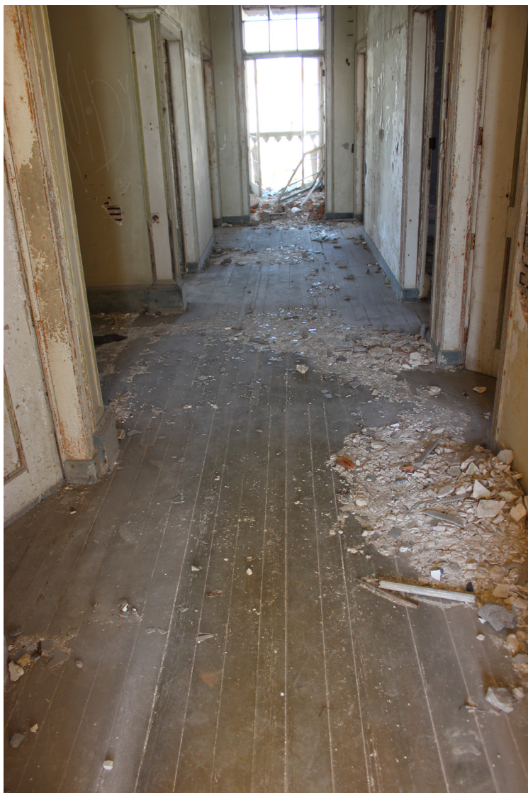
Corredor no piso 1
