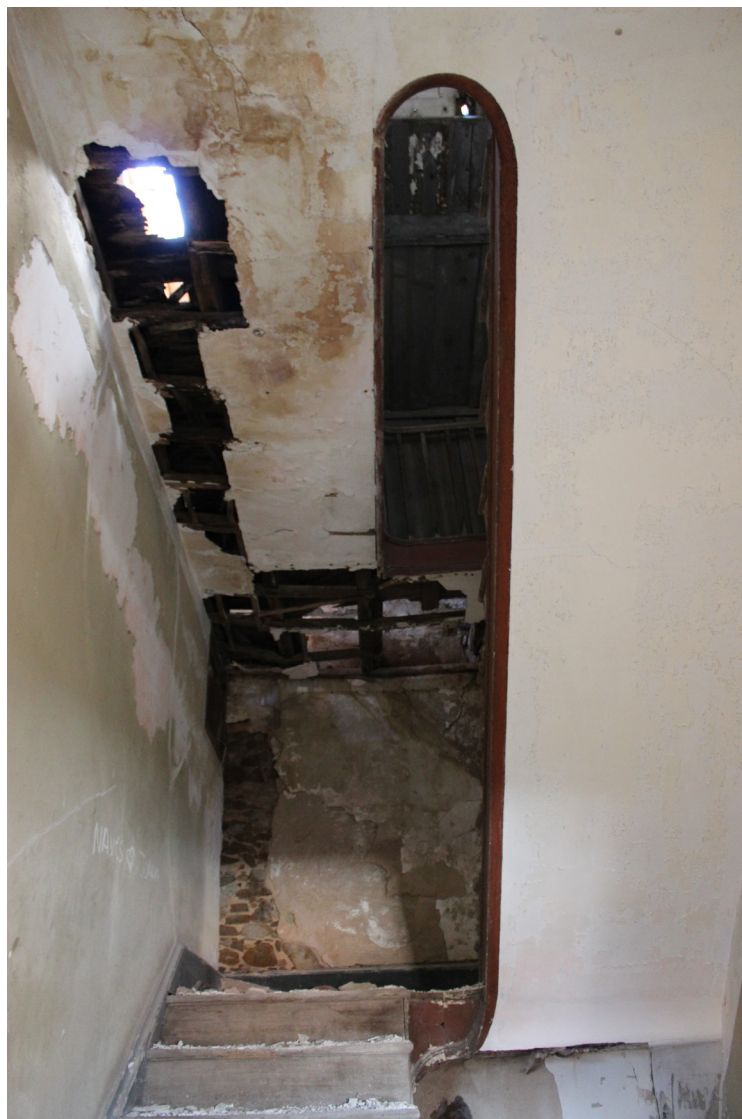
Escadas no piso 1
