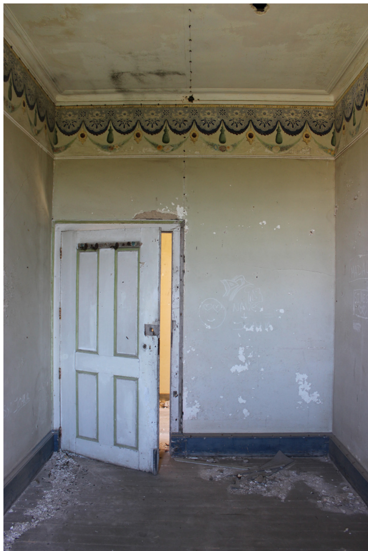
Quarto no Piso 1
