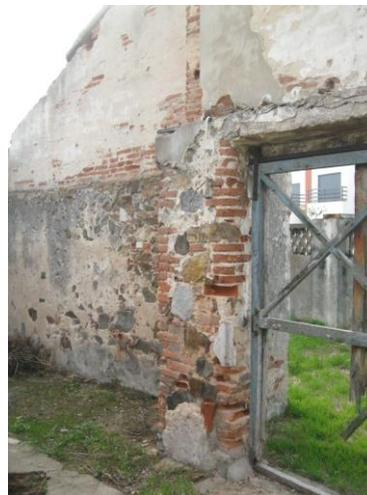
Figura 89 - Estrutura em tijolo
