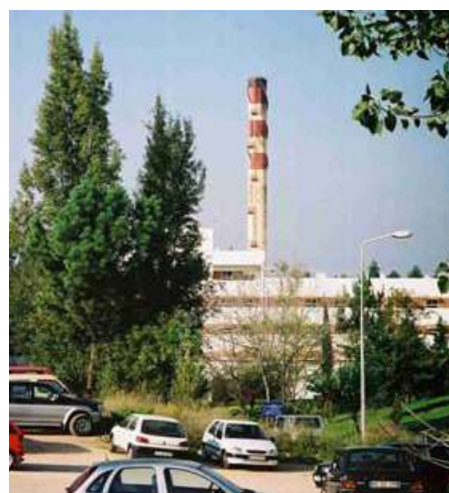
Fig. 3.202 - Instalações hospitalares e a polémica chaminé da incineração (JLF, 2002).
