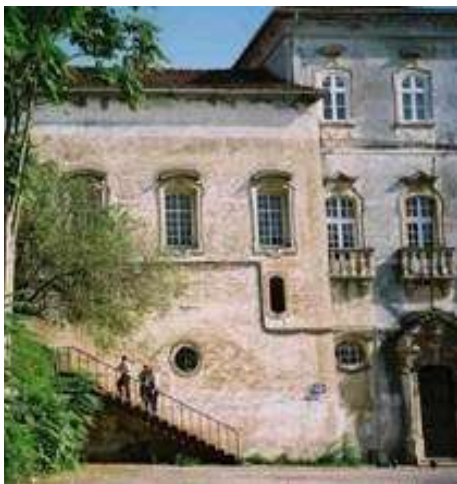
Fig. 3.126 - A Rua do Cotovelo após a demolição dos edifícios que a ladeavam (JLF, 2002).
