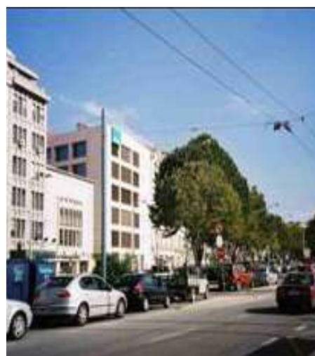
Fig. 3.102 - Frente edificada da Avenida Emídio Navarro voltada sobre o Rio Mondego (JLF, 2002).
