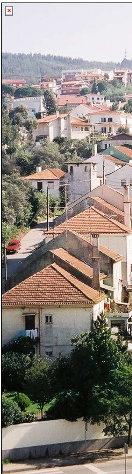
Fig. 1.27 - No último quartel do século XX a cidade periférica cresceu no sentido das áreas livres da Encosta dos Malheiros, favorecendo uma paulatina e menos regrada ocupação peri-urbana (JLF, 2002).
