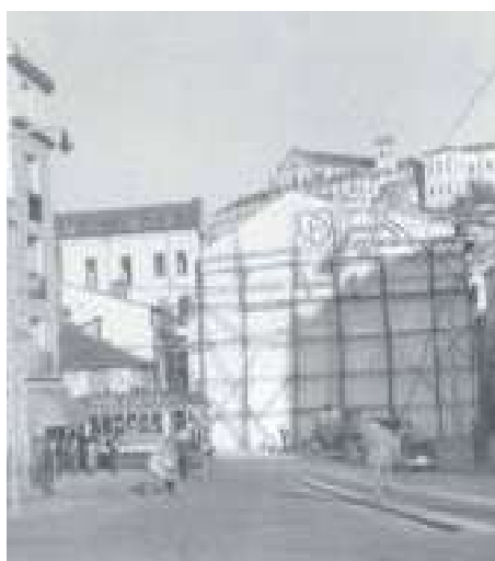
Fig. 3.83 - “1953 O Largo das Ameias sofre as primeiras demolições...” (Nunes, 1990, 142-143).
