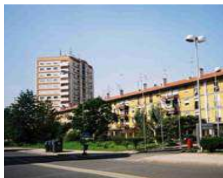
Fig. 3.178 - Rua General Humberto Delgado na Unidade Residencial do Calhabé (JLF, 2002).
