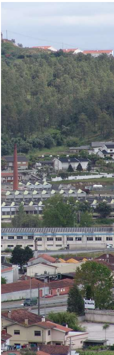
Fig. 1.6 - Os Fornos integram uma crescente área industrial e residencial da cidade periférica que urge requalificar (JLF, 2002).
