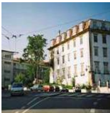
Fig. 3.116 - O Largo D. Dinis depois das obras de demolição do Arco do Castelo e do rebaixamento do Largo do Castelo (AAEC, 1984, 19).
