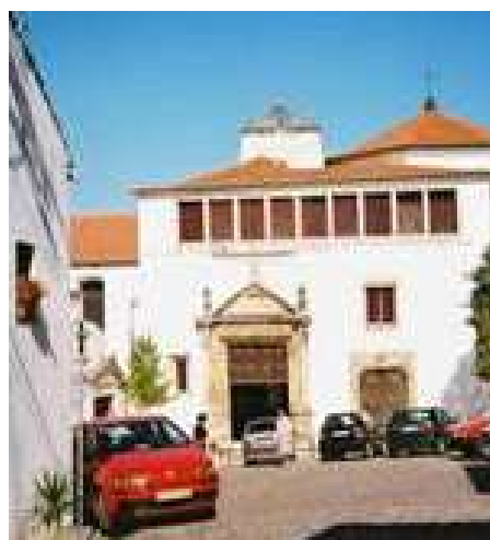
Fig. 3.25 - Alçado principal do Mosteiro de Celas (JLF, 2002).
