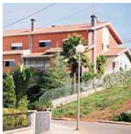
Fig. 3.196 - A expressão arquitectónica na Urbanização da Tamonte é o resultado de variadas relações plásticas (JLF, 2002).
