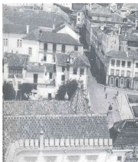
Fig. 3.16 - Casario antigo demolido para construção da cidade universitária (AAEC, 1984, 4).
