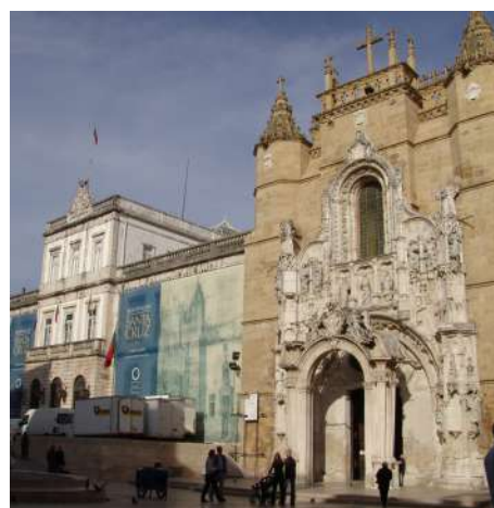
Fig. 3.64 - A Praça 8 de Maio, a Igreja de Santa Cruz e o Edifício dos Paços do Concelho (JLF, 2004).
