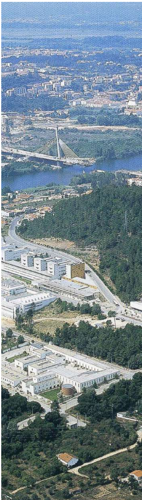
Fig. 5.1 - Uma vista aérea sobre Coimbra evidenciando uma área periurbana a sul no sentido de Santa Clara, com o Campus Universitário e a nova Ponte da Rainha Santa, expressando um imparável crescimento da franja urbana (FJ & JAB, 2003).
