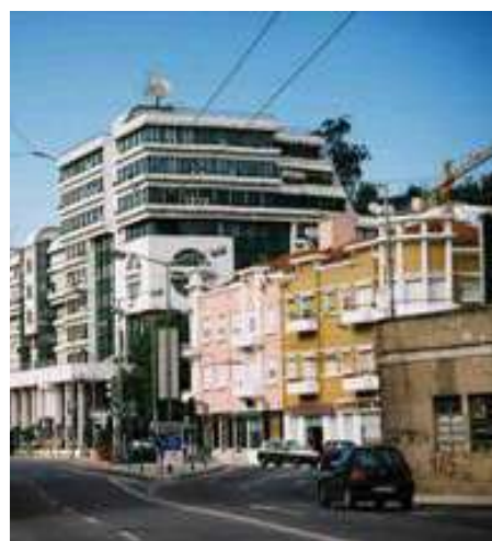
Fig. 3.90 - A Avenida Fernão de Magalhães no troço próximo ao Arnado (JLF, 2002).
