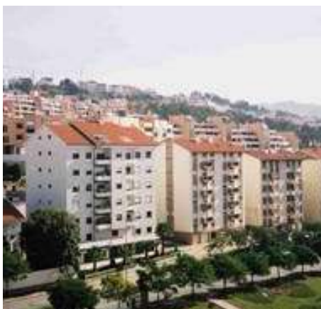
Fig. 3.219 - Expressão do edificado até à década de 1980, enquanto se projectavam as obras da Avenida Fernando Namora (JLF, 2002).
