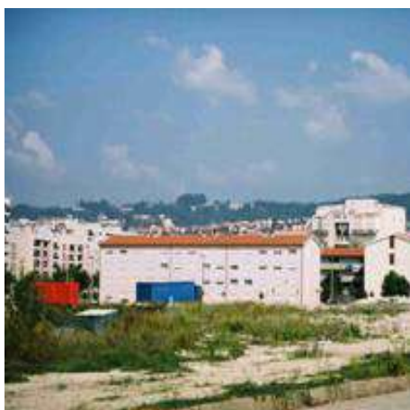
Fig. 3.204 - A habitação social tomou assento neste quarteirão periférico, em data anterior à consolidação da Avenida do Vale das Flores (JLF, 2002).
