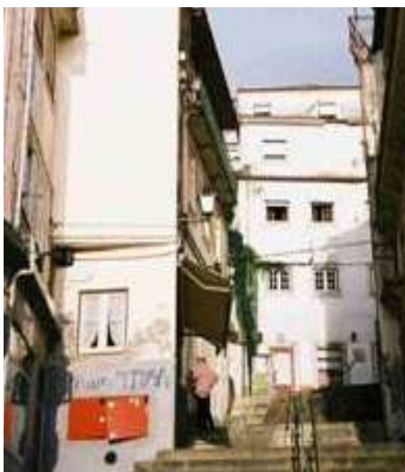
Fig. 3.62 - O primeiro lanço das Escadas do Quebra-Costas (JLF, 2002).
