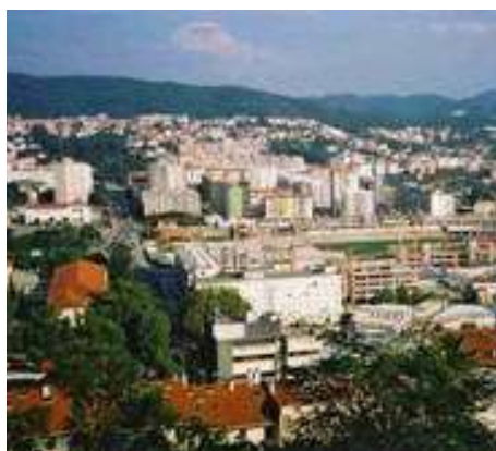
Fig. 3.141 - O Calhabé e o Bairro da Solum vistos do Penedo da Saudade - o Estádio Municipal de 1940 e 1960 em obras de transformação para o Euro 2004 (JLF, 2002).
