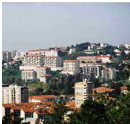
Fig. 3.192 - Panorâmica sobre a Urbanização da Cumeada (em cima) e a Urbanização do Casal da Eira (em baixo) (JLF, 2002).
