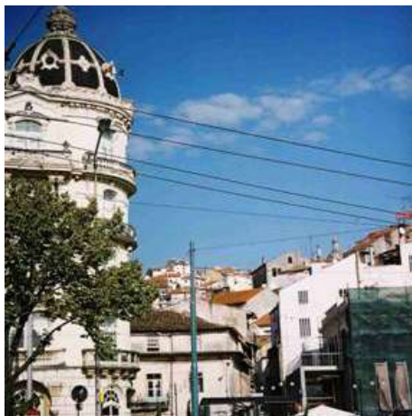
Fig. 3.54 - No Largo da Portagem sobressai o edifício do Hotel Astória (JLF, 2002).
