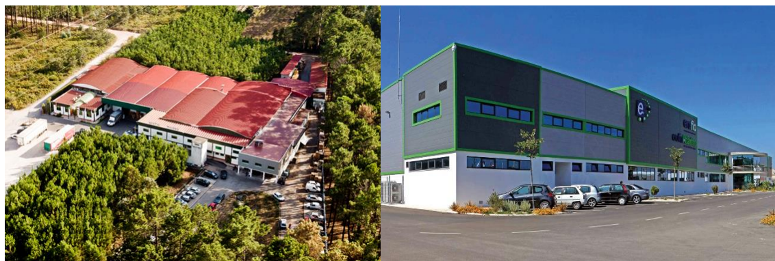
Figura 2 – O antes e depois das instalações do Grupo Erofio
