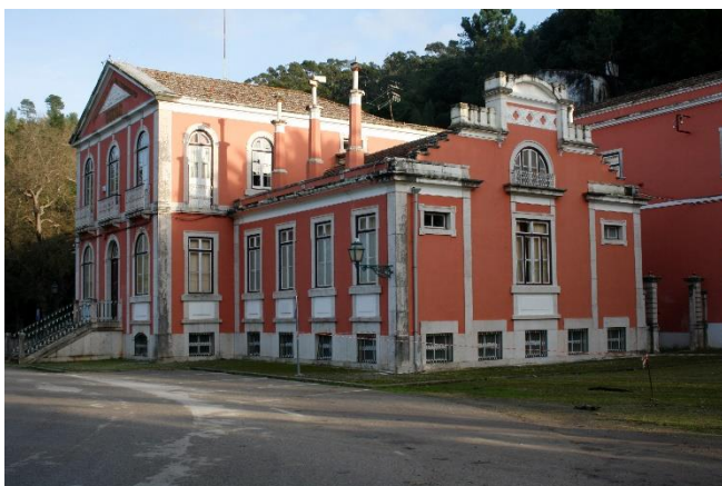
Foto 12 Fachada do edifício das Termas tomada do lado poente
