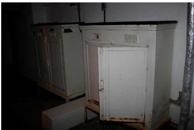
Foto 28 Estufas para aquecimento da roupa que era distribuída aos utentes
