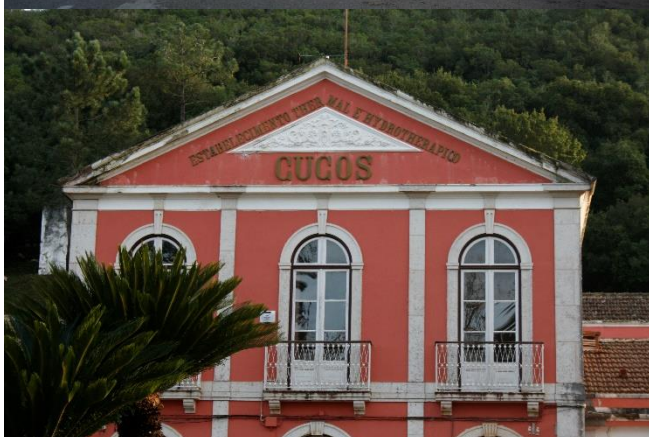
Foto 13 Pormenor da fachada do edifício das Termas ao nível do primeiro andar
