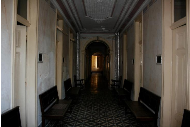
Foto 20 Corredor com salas de banhos de um lado e do outro
