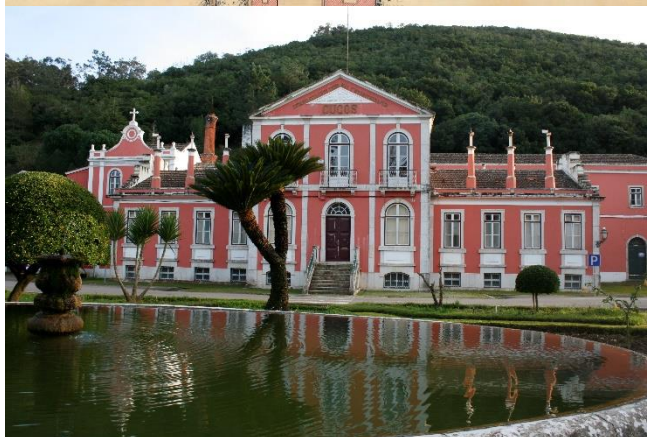
Foto 11 Fachada do edifício das Termas
