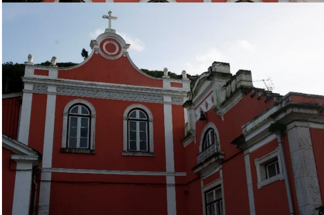
Foto 14 Janelas da Capela existente ao nível do primeiro andar com ligação direta ao piso de habitação
