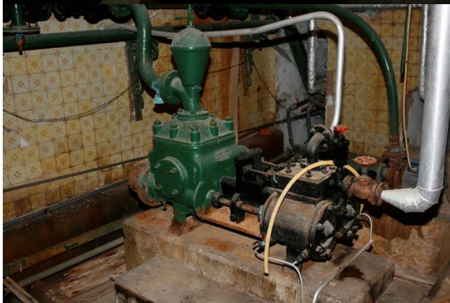
Foto 31 Casa das máquinas com as bombas de água
