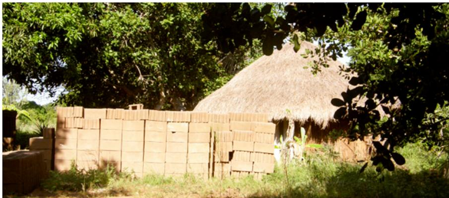
Figura 3.12 | Blocos de terra e cimento, à espera do início de uma nova construção.
