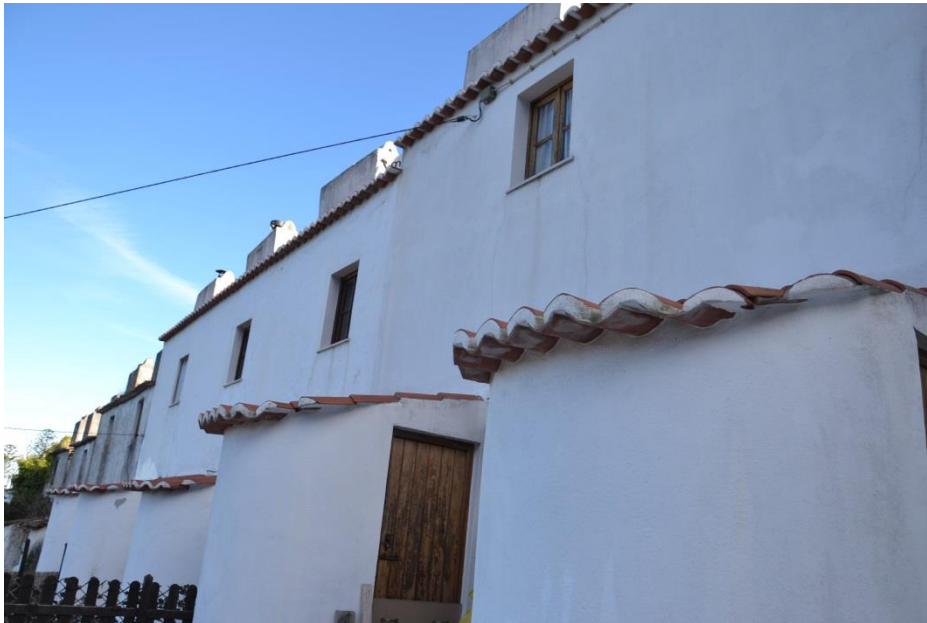
Figura 13 – Logradouros nas traseiras com acesso pela cozinha. Elaborada pelos autores, 2016.
