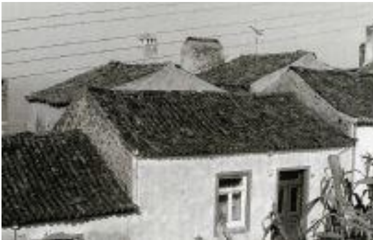
Figura 27 – Detalhe do sistema de agregação por empena, na Feteira Pequena, S.Miguel. Vasconcelos, 2015. Seriação da casa saloia na Região de Lisboa. O caso do Bairro dos Ilhéus na Picanceira, Mafra. Conslt. 03 de nov. 2016] Disponível em: http://hdl.handle.net/10400.5/8930
