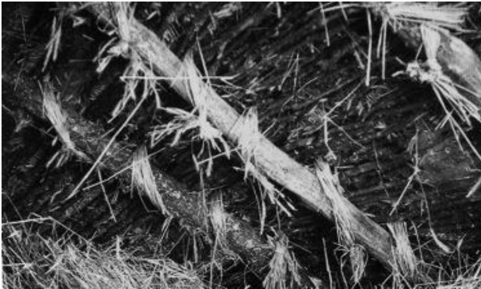
Figura 18 - Interior de uma cobertura em colmo onde são visíveis os bancelho , amarrando o ripado de varedo , imagem retirada do livro “Construções Primitivas em Portugal”.
