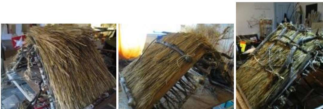
Figura 28 - Colocação do colmo correspondente à cumeada (foto trabalho da autora)
