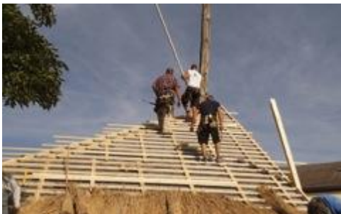
Figura 24 -Aplicação da cobertura em colmo na casa Storkhouse . retirada do site www.raidingfoundation.org (acedido em 22/02/2014).
