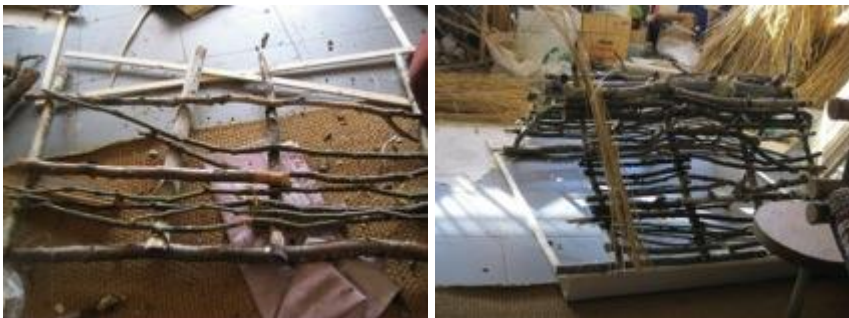
Figura 24 - Depois de preparado o material (palha de centeio), inicia-se a construção da estrutura em madeira, que irá sustentar a cobertura (colocação dos varedos / caibros , troncos que irão compor cada água do telhado (foto trabalho da autora).
