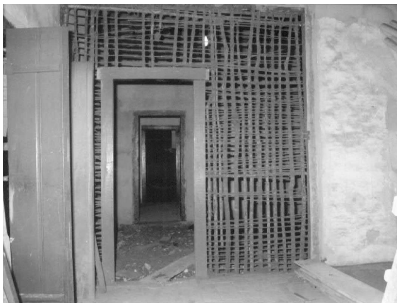
Figura 3. Interior do Casarão Pau Preto, estruturas em Taipa de Mão, Áreas com remoção do preenchimento argiloso original, Arquivo Fundação Pró-Memória de Indaiatuba, Foto de Silva e Pena, Álbum Fotográfico Digital, c. 1983.
