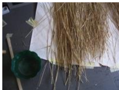
Figura 23 - Preparação do material (humidificação da palha para posterior colocação). A palha é espalhada e separada, retirando algumas das impurezas e as palhas mais finas (foto trabalho da autora).
