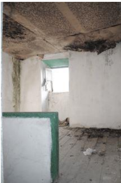
Figura 20 – O quarto. Vasconcelos, 2015. Seriação da casa saloia na Região de Lisboa. O caso do Bairro dos Ilhéus na Picanceira, Mafra. Constl. 03 de nov. 2016] Disponível em: http://hdl.handle.net/10400.5/8930
