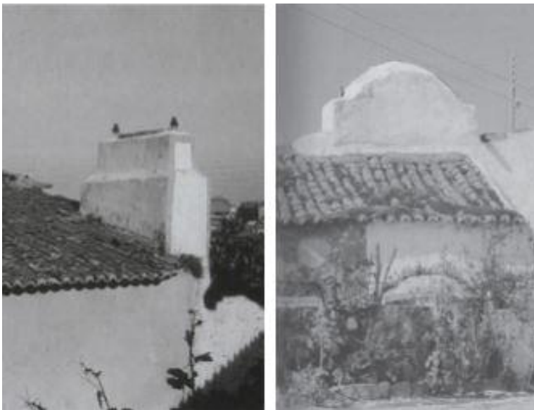
Figura 22 – Dois tipos de chaminés comuns nas casas saloias. Vasconcelos, 2015. Seriação da casa saloia na Região de Lisboa. O caso do Bairro dos Ilhéus na Picanceira, Mafra. Conslt. 03 de nov. 2016] Disponível em: http://hdl.handle.net/10400.5/8930
