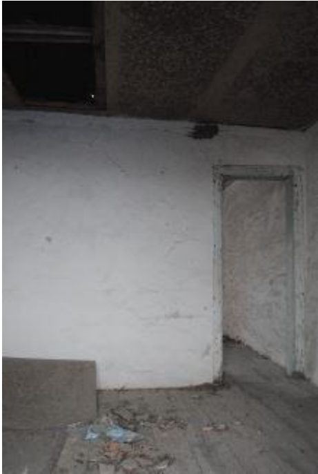
Figura 19 – A casa-de-fora. Vasconcelos, 2015. Seriação da casa saloia na Região de Lisboa. O caso do Bairro dos Ilhéus na Picanceira, Mafra. Constl. 03 de nov. 2016] Disponível em: http://hdl.handle.net/10400.5/8930
