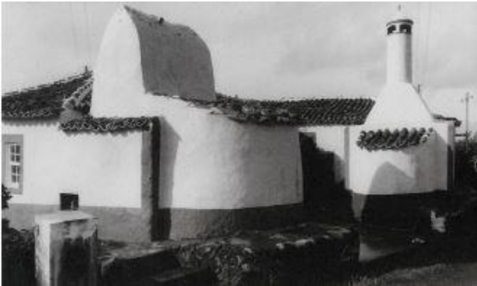
Figura 21 – Dois tipos de chaminés comuns nas ilhas de S.Miguel e Santa Maria. À direita a chaminé “mais antiga” e à esquerda a chaminé de vapor. Vasconcelos, 2015. Seriação da casa saloia na Região de Lisboa. O caso do Bairro dos Ilhéus na Picanceira, Mafra. Conslt. 03 de nov. 2016] Disponível em: http://hdl.handle.net/10400.5/8930
