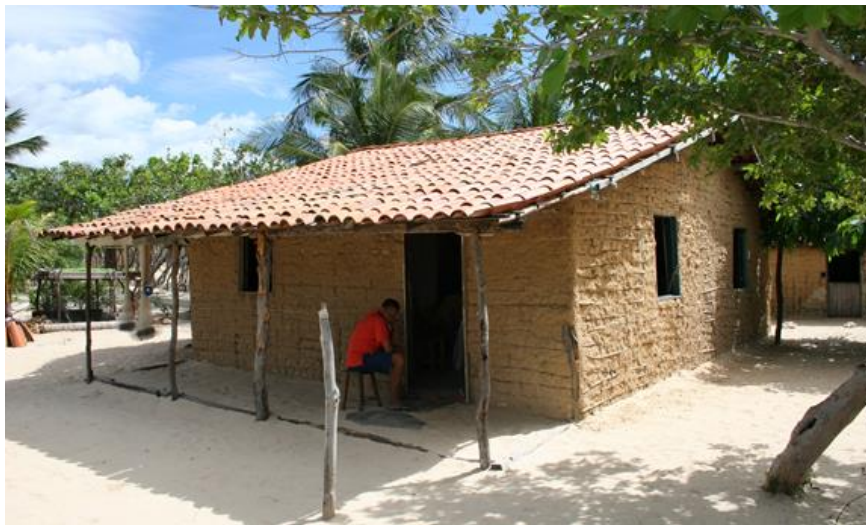
Figura 6 Casa em taipa, Quitéria – CE, Planta baixa, perspectiva estrutura, foto Fonte: desenvolvimento e acervo do autor
