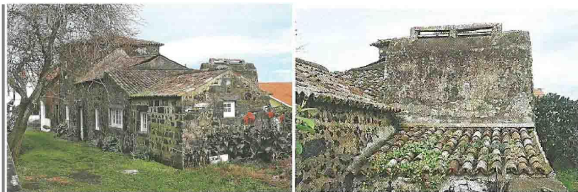
Figura 4 - Construção 2. Anexos em alvenaria de pedra. Adaptado do Inventário do Património Imóvel dos Açores.
