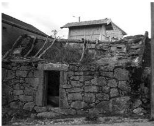
Figura 15 - Casa em ruínas com vestígios de estrutura suporte de cobertura em colmo em Paredes do Rio, Montalegre 2016 (foto da autora).
