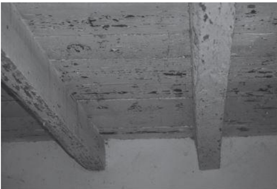
Figura 17 – Estrutura do pavimento do sobrado e do teto no piso inferior. Vasconcelos, 2015. Seriação da casa saloia na Região de Lisboa. O caso do Bairro dos Ilhéus na Picanceira, Mafra. Conslt. 03 de nov. 2016] Disponível em: http://hdl.handle.net/10400.5/8930
