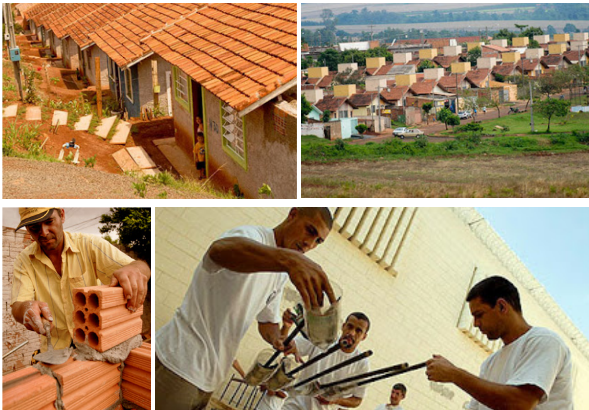
Fig. 2, 3, 4 e 5: processos de autoconstrução assistida no Brasil.
