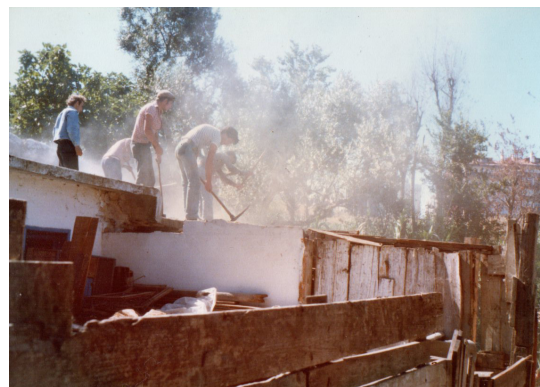
Fig. 25: Demolição das barracas feita pelos moradores.
