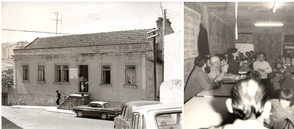
Fig. 14 e 15: Foto da 1ª Sede da Associação e foto da Sede no estaleiro de obra.
