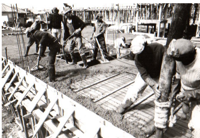
Fig.18: Foto dos sócios a trabalhar na obra.
