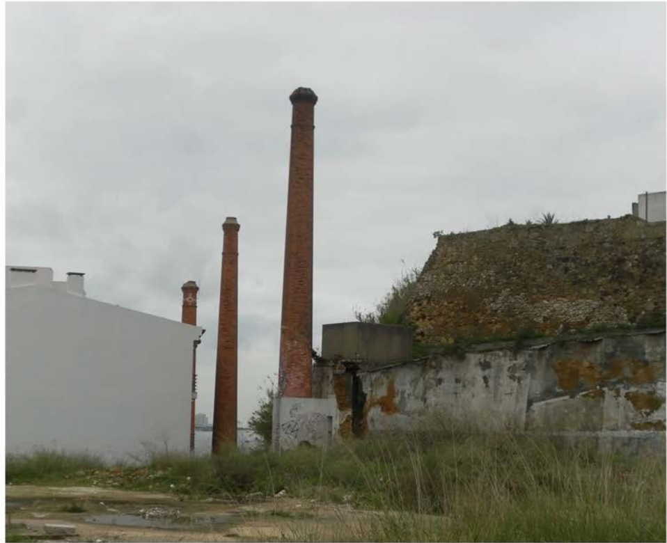
Fig. 7 - Local de Intervenção
