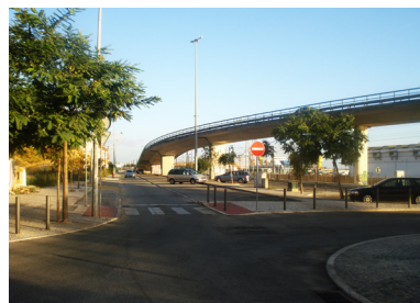
Figura 14 Viaduto e ferrovia da Estrada da Graça.
