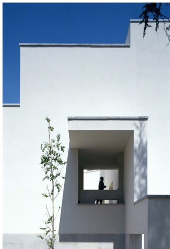
Figura 2.5 - Fundação Serralves, Álvaro Siza Vieira
