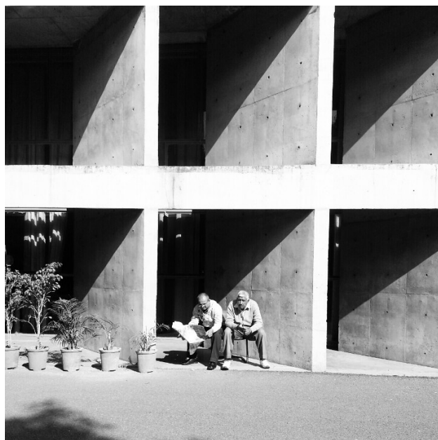
Figura 2.8 - Secretariado em Chandigarh, Le Corbusier
