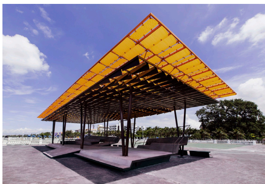
Figura 4.7 - Sistema de sombreamento composto por duas camadas
