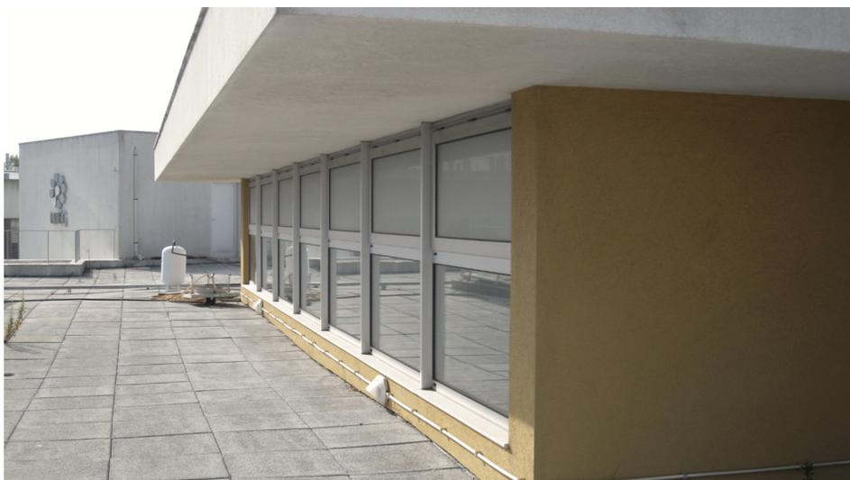
Figura 10 Aberturas para ventilação no topo do edifício Solar XXI
