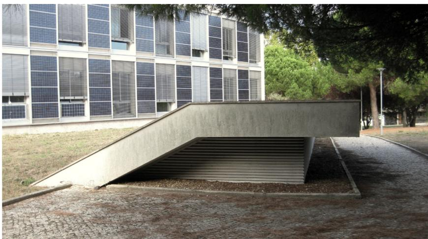
Figura 14 - Poço de admissão de ar do sistema de tubagem subterrânea do edifício Solar XXI
