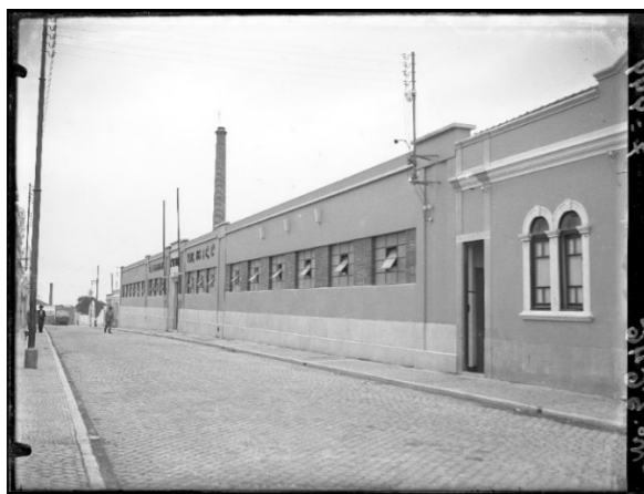
Figura 31 Número 16 - Fábrica de conservas Marques Neves. Aspeto exterior depois de obra, 1949. AR5646 1, Arquivo fotográfico Américo Ribeiro. [Acessível Casa Bocage]
