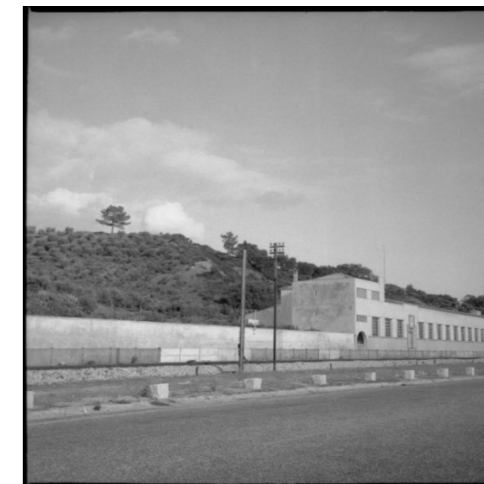
Figura 44 Número 69 - Fábrica de conservas Vasco da Gama. Aspeto exterior, 1972. AR14592, Arquivo fotográfico Américo Ribeiro. [Acessível Casa Bocage]
