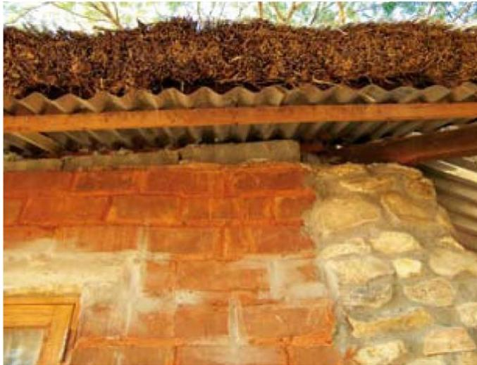
Figura 43 - Exemplo de cobertura mista (palha/colmo e chapas de zinco) (Guedes et al., 2011 p.52).
