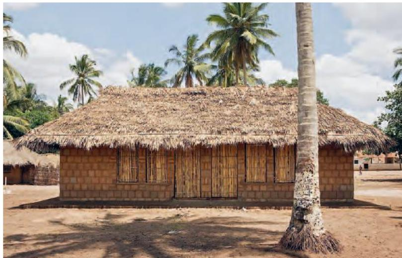
Figura 53 – Construções em Cabo Delgado, evidenciam utilização de materiais e técnicas locais como bambu e capim na cobertura e vãos, e blocos de terra. (Earth architecture. [Online] [Consult. 20 de Setembro de 2015.] Disponível em <http://www.eartharchitecture.org/index.php/?archives/1153-Habitat-Cabo-Delgado.html>)
