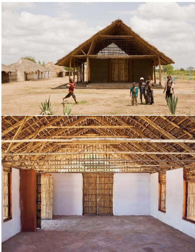
Figura 52 – Construção atual em Cabo Delgado, cobertura, janelas e portas feitos com materiais e técnicas locais - bambu (Earth architecture. [Online] [Consult. 20 de Setembro de 2015.] Disponível em <http://www.eartharchitecture.org/index.php/?archives/1153-Habitat-Cabo-Delgado.html>)
