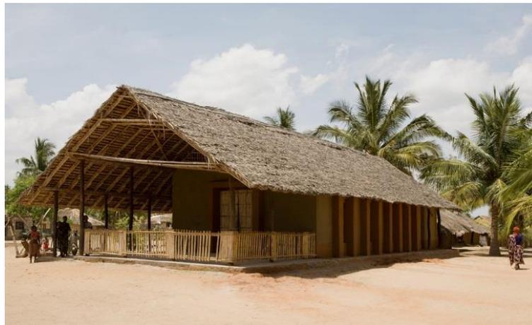
Figura 51 – Fundação Aga Khan em Cabo Delgado, evidenciam utilização de materiais e técnicas locais como bambu e capim na cobertura e vãos, e blocos de terra. (Earth architecture. [Online] [Consult. 20 de Setembro de 2015.] Disponível em <http://www.eartharchitecture.org/index.php?/archives/1153-Habitat-Cabo-Delgado.html>)
