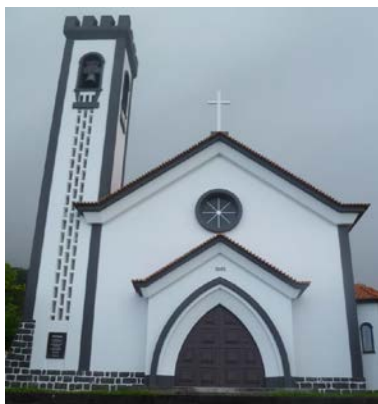
Figura 68 – Igreja de Santa Bárbara da freguesia das Ribeiras (ver figuras 110, 126, 174 e 175).
