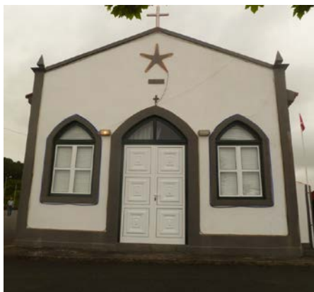
Figura 54 – Ermida da localidade do Campo Raso, freguesia da Candelária (ver figuras 110, 114 e 135).
