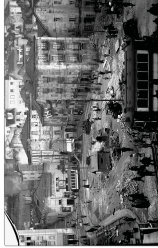
Imagem 2 A e B Demolições e espaço aberto para a construção da Praça do Martim Moniz. Eduardo Portugal, 1947. PT/AMLSB/EDP/000951 e PT/AMLSB/EDP/000948. Arquivo Municipal de Lisboa./Núcleo Fotográfico
