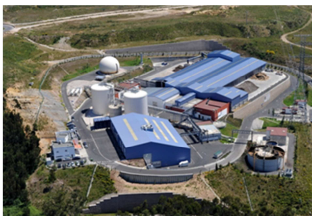
Figura 31 - Vista aérea da central de valorização orgânica
