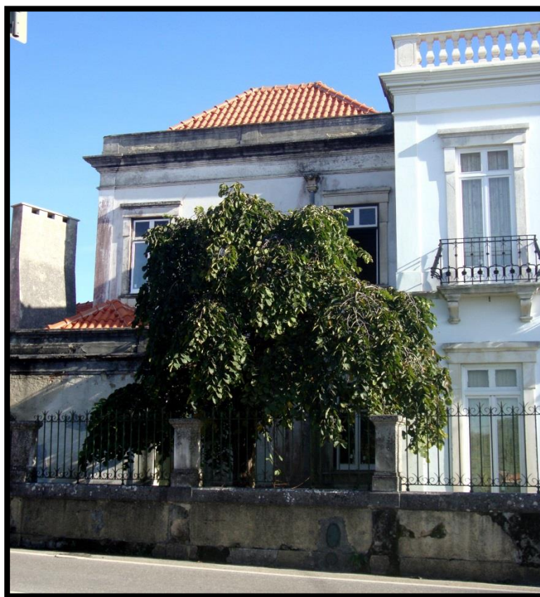
Img. 11 – parte frontal por reconstruir
