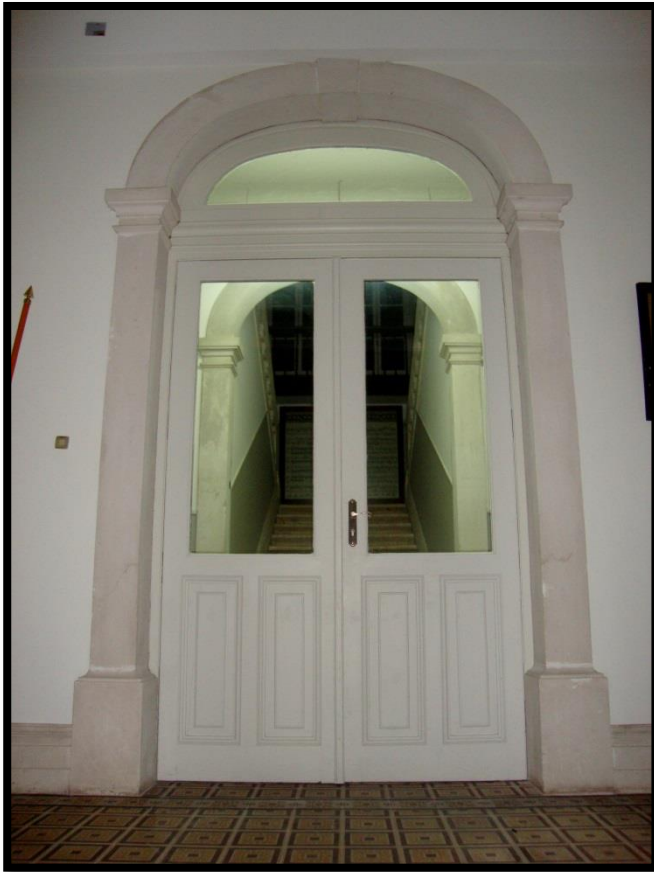
Img. 7 – entrada principal (inoperacional)
