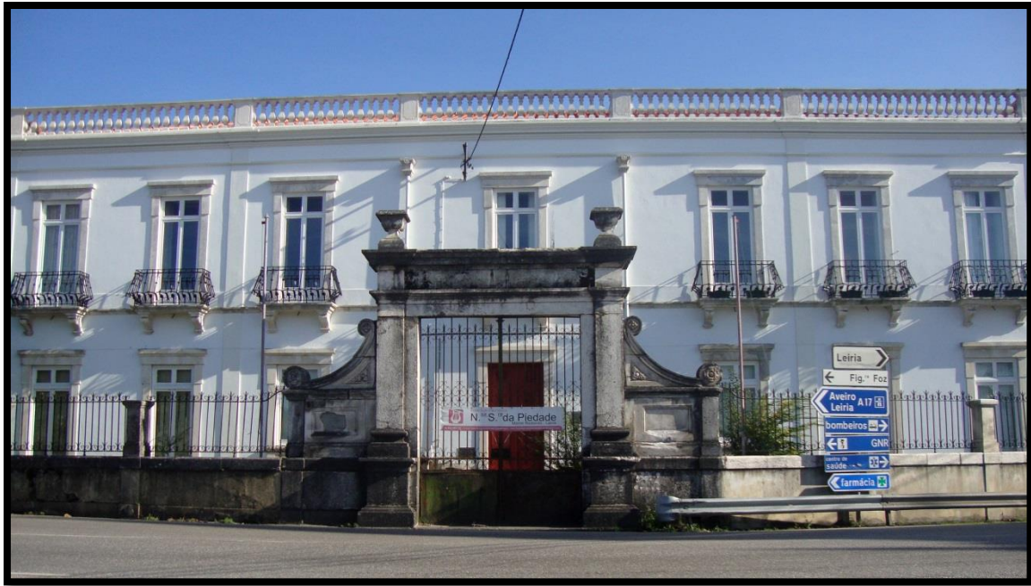
Img. 12 – antiga entrada principal por reconstruir e edifício totalmente recuperado exteriormente
